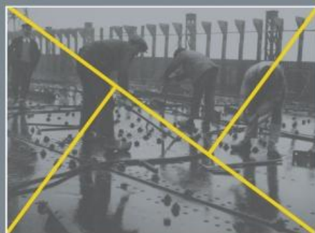
Construction des grands paquebots, rivetage de tôles d'un pont de navire, chantier et ateliers de Saint-Nazaire à Penhoët (1931-1932).
