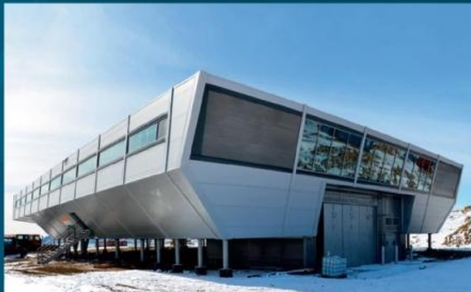
Bharati, la base futuriste indienne, est composée de 134 conteneurs posés sur pilotis.
