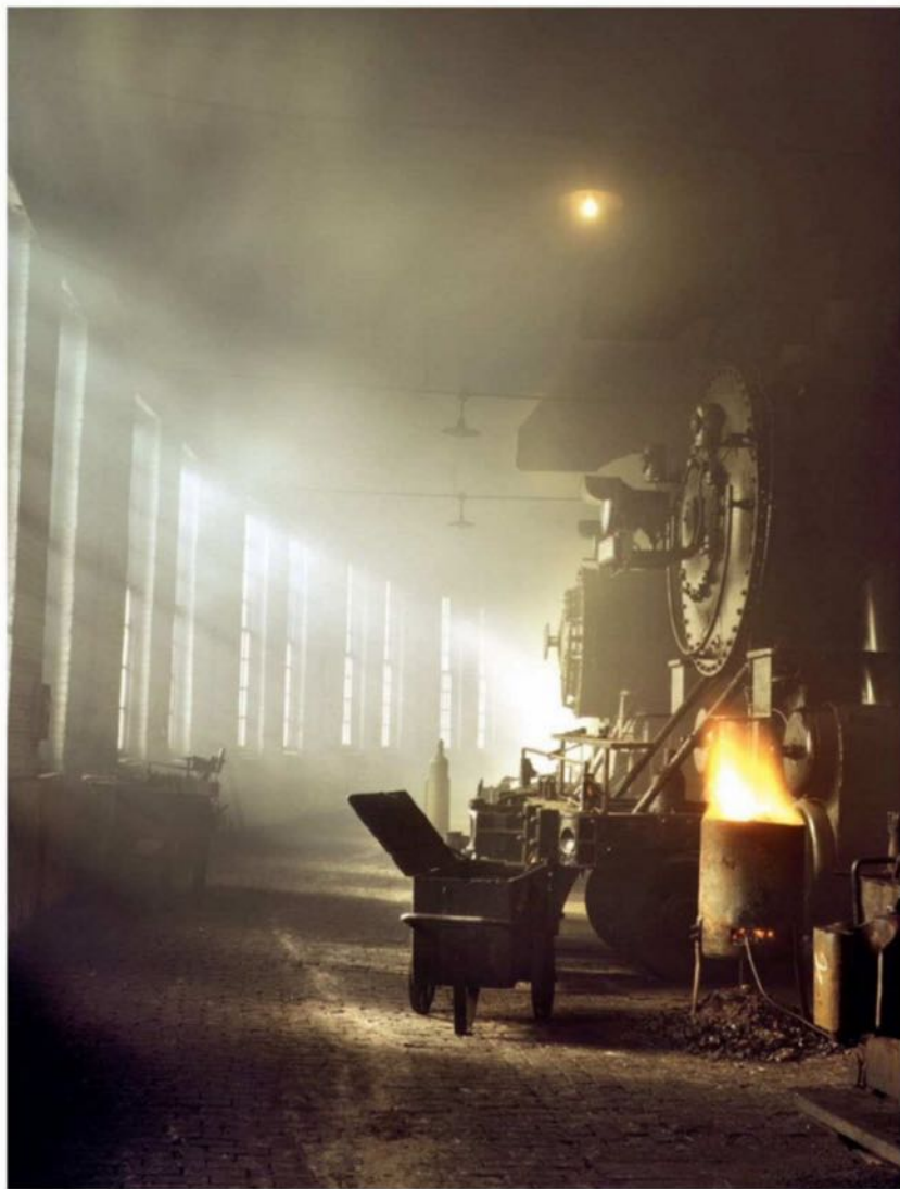
Dans la rotonde de la North Western Railway, une locomotive montée sur un poste de levage s'apprête à subir la révision de ses essieux.
