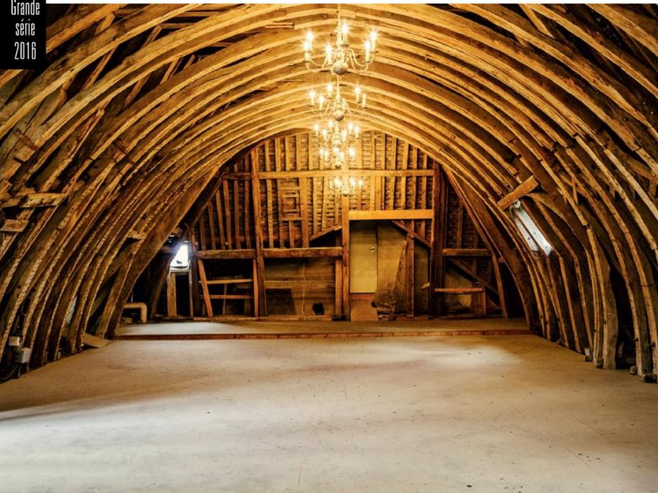
Le château de Châteaugiron (ici, sa splendide charpente d'origine datant de 1480) était placé sur la ligne de frontière avec le royaume de France.
