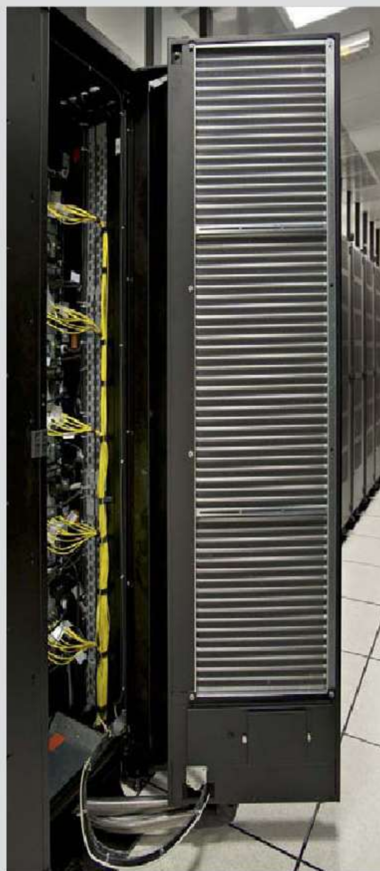
Les portes froides améliorent l'efficacité du refroidissement et limitent les points chauds.
