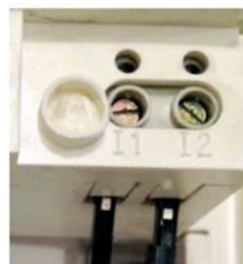
Les prises 11 et 12 du compteur qui permettent de récupérer la téléinformation.
