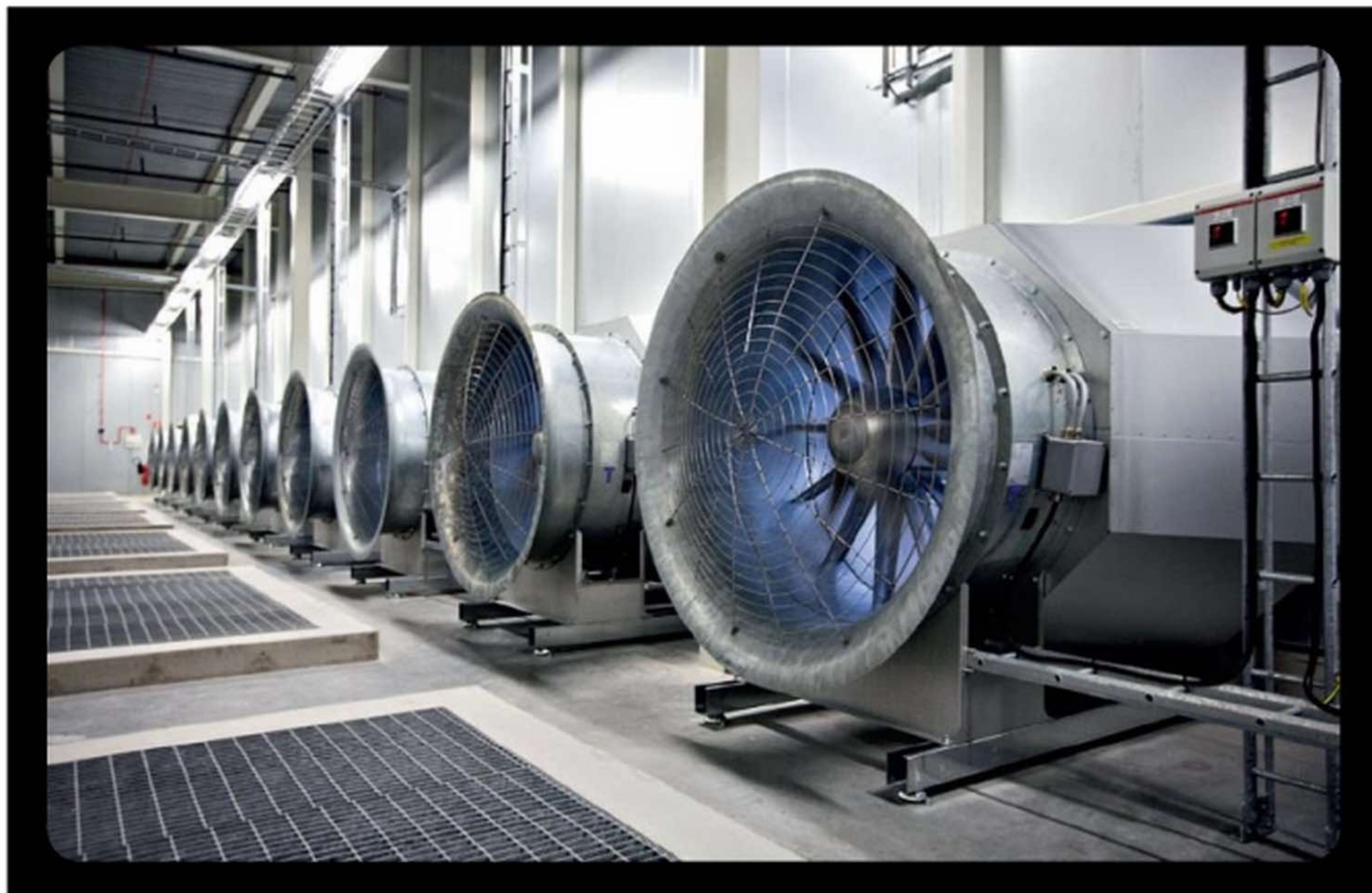
Avec son data center installé dans la petite ville de Luleå, Facebook fait coup double : il profite de l'air polaire gratuit (brassé par ces gros ventilateurs) pour refroidir ses ordinateurs et s'attire les félicitations de Greenpeace.
