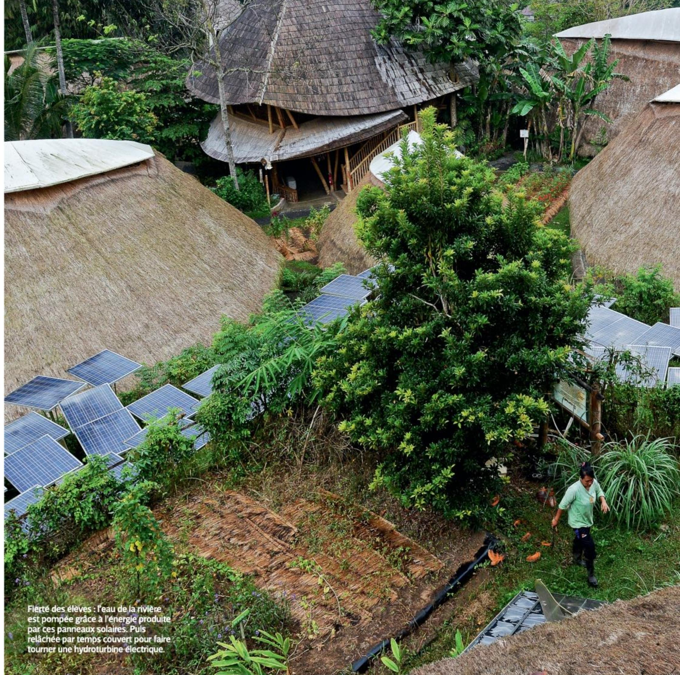
Fierté des élèves : l'eau de la rivière est pompée grâce à l'énergie produite par ces panneaux solaires. Puis relâchée par temps couvert pour faire tourner une hydroturbine électrique.
