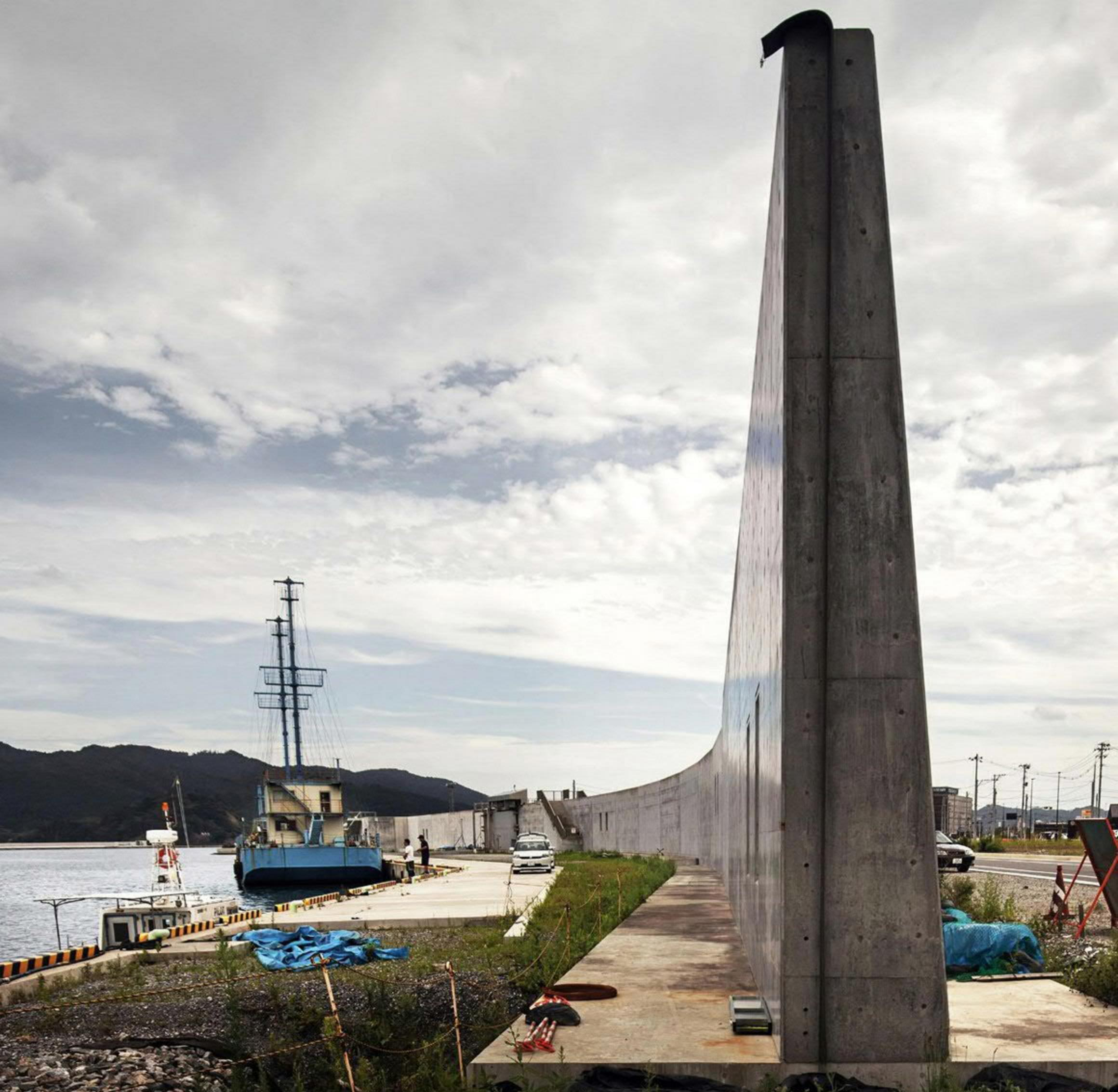
Un rempart de béton armé de 8,7 m de haut se dresse devant le port d'Ofunato, coupant les pêcheurs du reste de la ville. La commune déplore plus de 300 morts dans le tsunami. Au Japon, ces murailles géantes ont été proposées aux habitants dès 2011. Encore sous le choc, la plupart ont donné leur accord.
