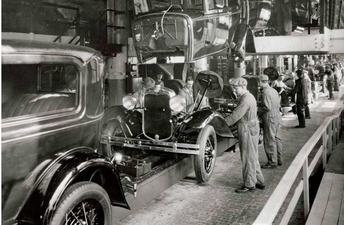
Postés le long d'une chaîne de montage, des ouvriers de la Ford Motor Company construisent une Ford T.
