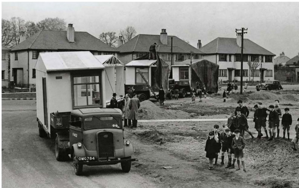
En 1946, des éléments de maisons préfabriquées arrivent sur un chantier de construction pour y être assemblés.
