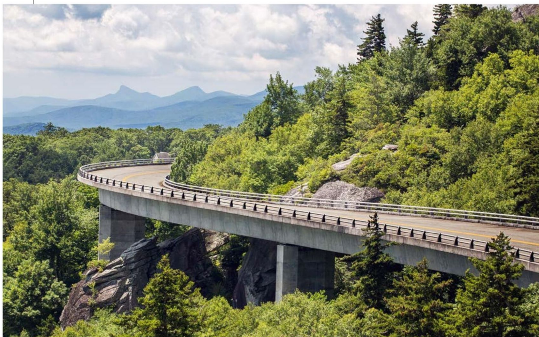
Le viaduc Linn Cove, construit entre 1979 et 1983, est devenu le symbole de la Blue Ridge Parkway.
