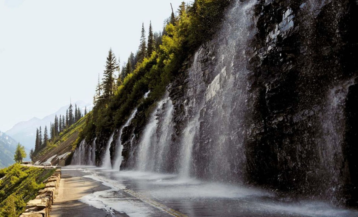
Alimenté par la fonte des neiges, le Weeping Wall (le mur en pleurs) arrose continuellement la route.
