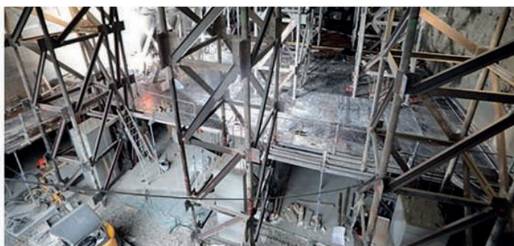
Sur ouvrage existant REZ + 5 : reprise en sous œuvre générale sur 3 niveaux en micropieux et soutènements
