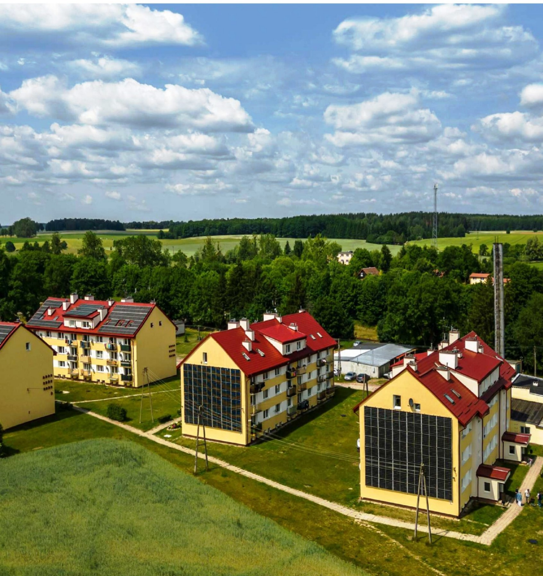
↑ Un système de pompes à chaleur et des panneaux photovoltaïques procurent le chauffage et l'électricité aux bâtiments du complexe Ceramik, à Ceglów (nord-est de la Pologne), sans brûler le moindre gramme de charbon.
