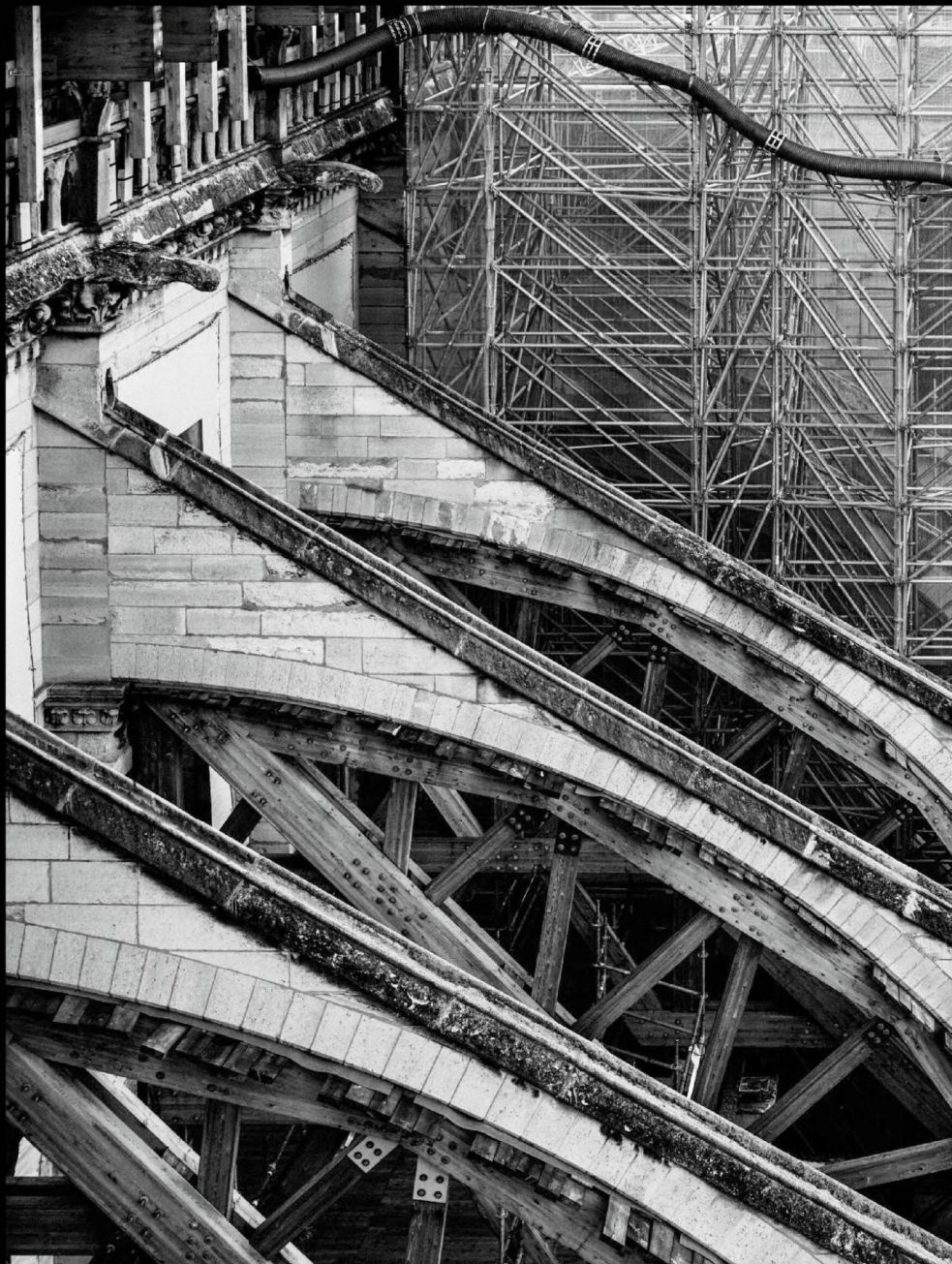
Après deux ans d'efforts pour étayer les contreforts et parer les façades d'une dentelle d'acier, la rénovation a pu commencer...
