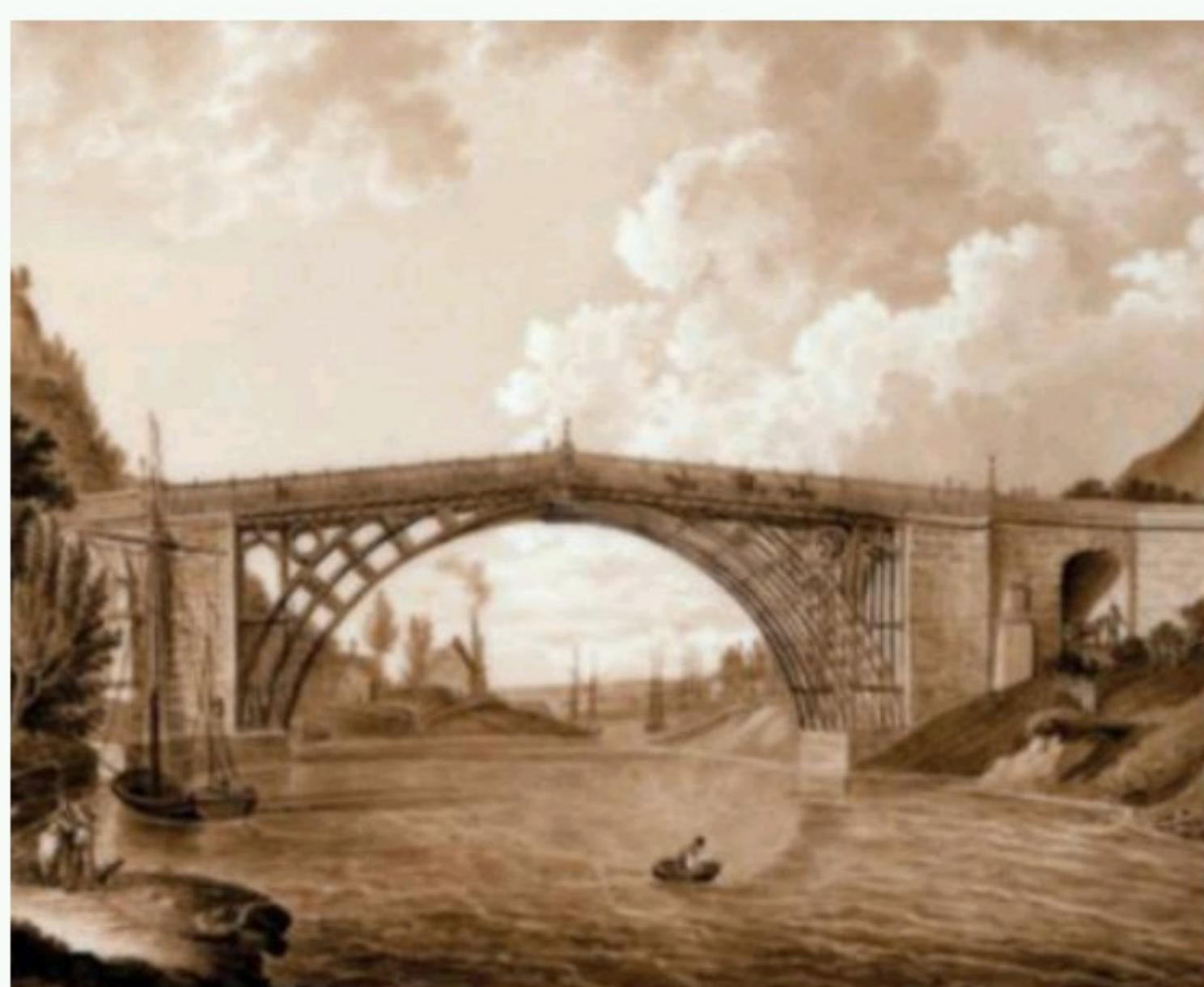
**LE PONT MÉTALLIQUE DE COALBROOKDALE.** Il enjambe le fleuve Severn et fut le tout premier pont courbe construit entièrement en fonte. Dessiné par Thomas Farnolls Pritchard en 1775, il mesure 60 m de long et s'élève à 30 m de hauteur. Ci-dessus, une vue du pont peinte sur un plateau en 1801. (The Granger Collection, New York.)
