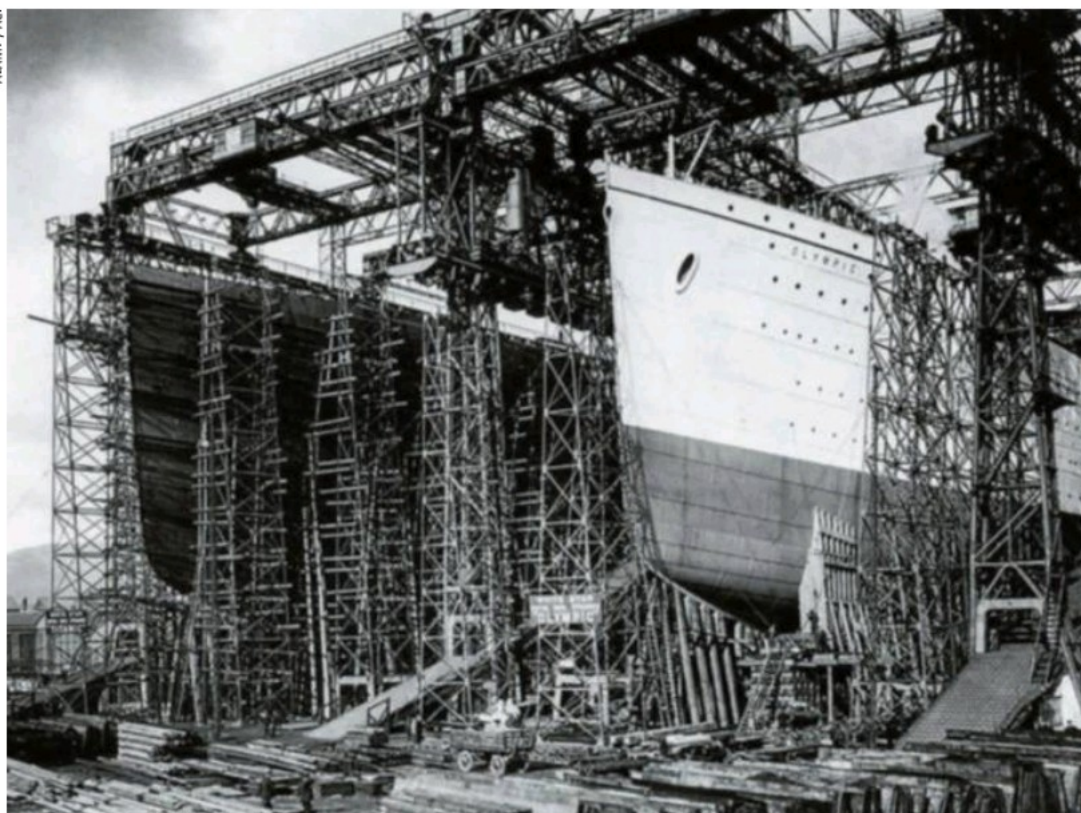
La coque du Titanic (à gauche) et celle de l' Olympic , plus avancée, sur leurs échafaudages de construction aux chantiers navals Harland & Wolff vers 1910.
