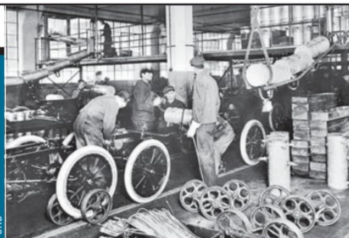
Dans l'usine Ford de Highland Park fut installée, en 1913, la première chaîne de montage au monde. Tous les constructeurs suivront.
