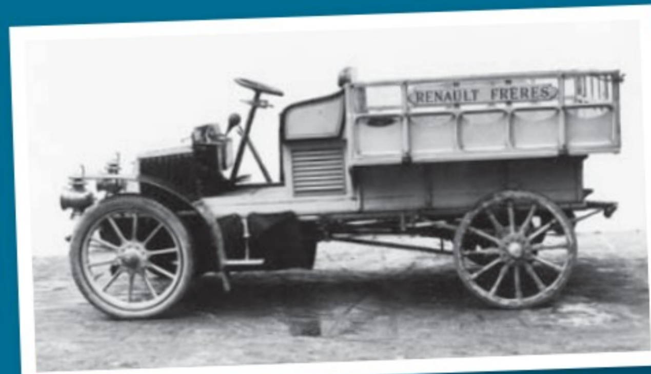
La première camionnette Renault Frères, à l'architecture encore très rudimentaire, disposait d'un moteur à cylindre unique développant 8 ch.
