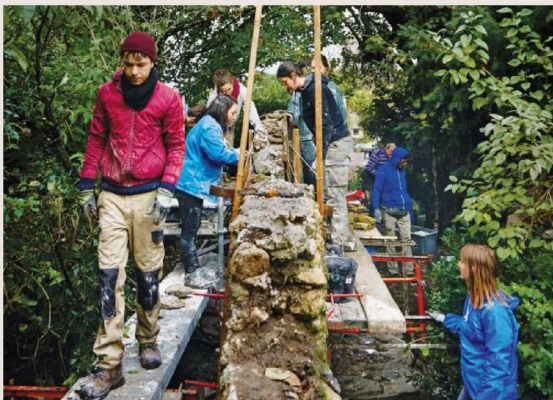
Des travailleurs restaurent les murs à pêches montreuillois avec des méthodes traditionnelles.
