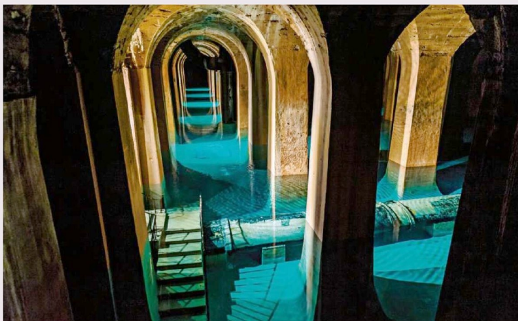
Le réservoir de Montsouris, colossal ouvrage du génie civil, fut construit sur des carrières multiséculaires. Sa structure est soutenue par 1800 piliers souterrains.
