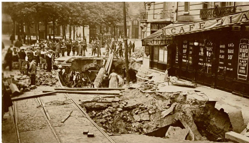
Le 15 juin 1914, l'affaissement de la chaussée, au coin des rues de la Boétie et du Faubourg-Saint-Honoré, pourrait avoir été provoqué par l'instabilité des sols après des orages ayant fragilisé les cavités souterraines.
