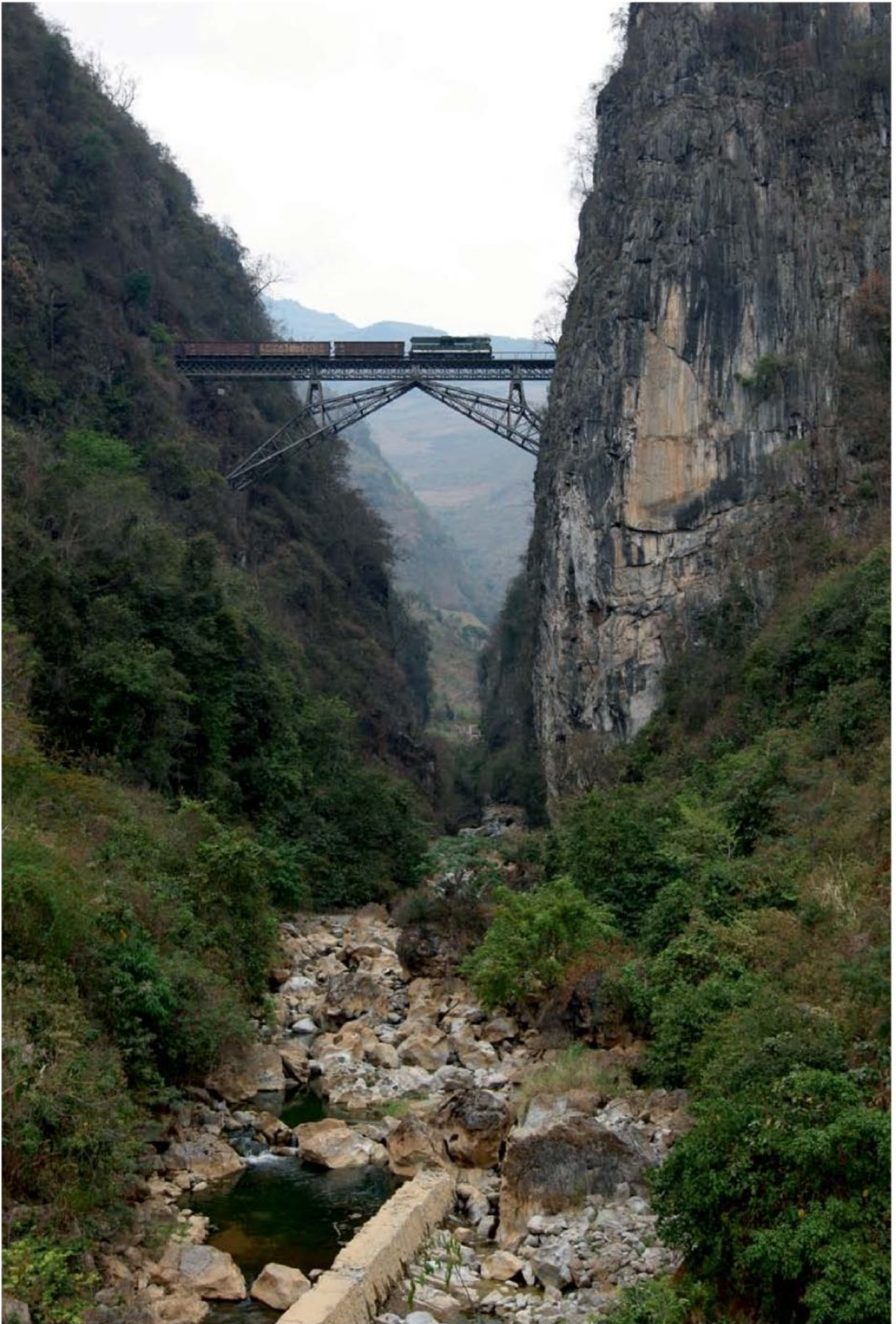
SUSPENDU AU-DESSUS DU VIDE Au kilomètre 111, le pont à arbalétriers surplombe une gorge profonde. Conçu par l'ingénieur français Paul Bodin, l'ouvrage a nécessité vingt et un mois de travaux. Mais cette merveille d'ingénierie a coûté la vie à 800 travailleurs, majoritairement chinois.
