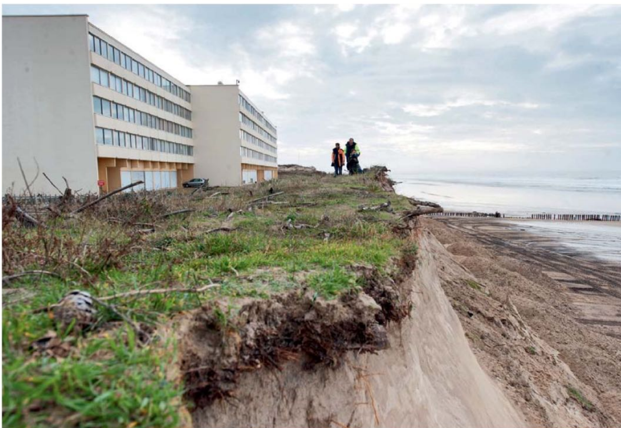
SANS PROTECTION CONTRE L'ÉROSION La résidence Le Signal était à 200 m du front de mer lors de sa construction, en 1967, à Soulac-sur-Mer (Gironde). Le préfet a ordonné son évacuation en janvier 2014. Le bâtiment n'est plus qu'à 15 m du bord de la dune.
