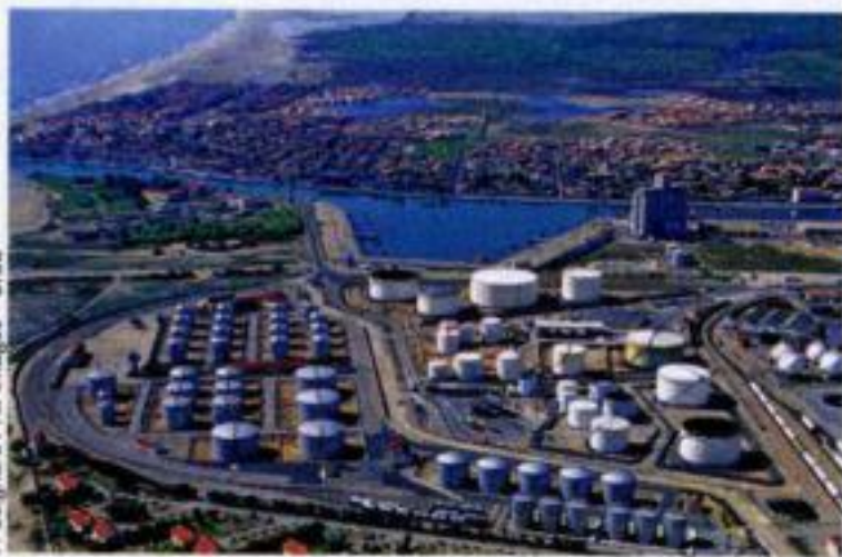
La construction d'un troisième quai permettrait de stabiliser les 610 emplois liés aux activités du port.
