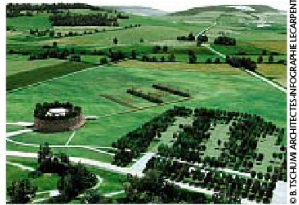
PANORAMA Le bâtiment du musée est enveloppé d'une résille de bois de mélèze, que César utilisait pour ses fortifications.
