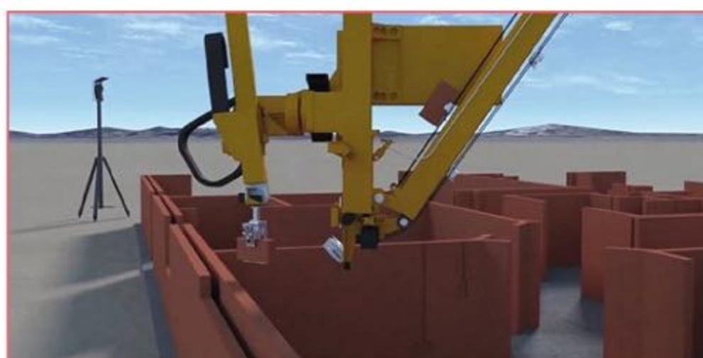
◀ LE STAKHANOV DU BÉTON. Baptisé Hadrien, ce cybermaçon mis au point par un ingénieur australien est capable d'empiler 1 000 briques à l'heure. Il lui suffit de mémoriser les plans en 3D de la future bâtisse pour se mettre au boulot.
