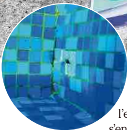
Le fabricant de la piscine a préconisé de carrelé la coque en polyester. Les carreaux se décollent...
