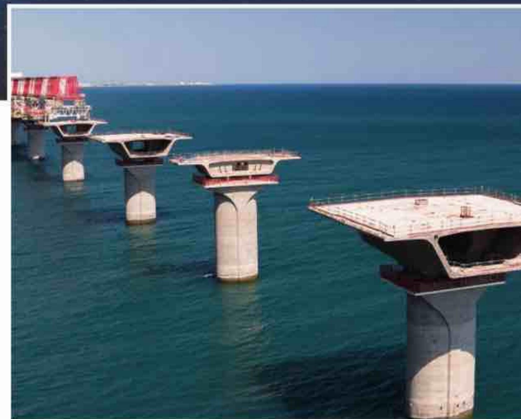
jusqu'à 30 m de hauteur. Avant d'arriver à ce résultat, il aura fallu embaucher 3 000 personnes sur le chantier, préfabriquer 50 appuis (dont 48 piles de pont), les transporter en mer et les positionner pour soutenir le tronçon du plus grand
