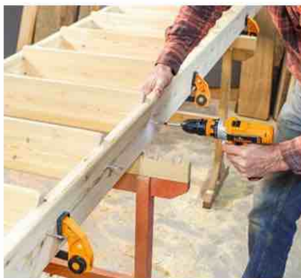
8 Emboîtez les marches dans les rainures. Bridez les limons, puis assemblez le tout avec des vis en Inox de 5 x 50 mm. Les têtes des vis ne doivent pas dépasser la face externe des limons.
