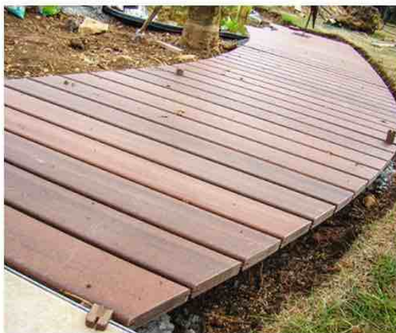
Les lames sont fixées sur les lambourdes et maintenues par des clips invisibles : « j'ai utilisé trois longueurs de lambourdes. Les découpes sont réalisées avec une défonceuse, un outil d'affleurage et des guides pour obtenir les courbes. »
