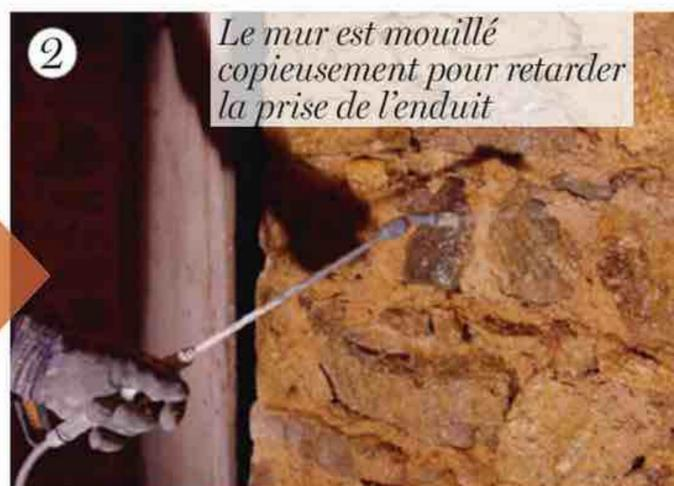
2 Le mur est mouillé copieusement pour retarder la prise de l'enduit
