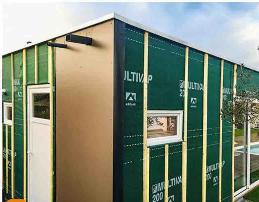
6 Côté jardin, les panneaux de finition sont fixés sur les tasseaux qui maintiennent le pare-pluie : « Je préfère ce type de panneaux, ils ne changent pas d'aspect dans le temps. »
