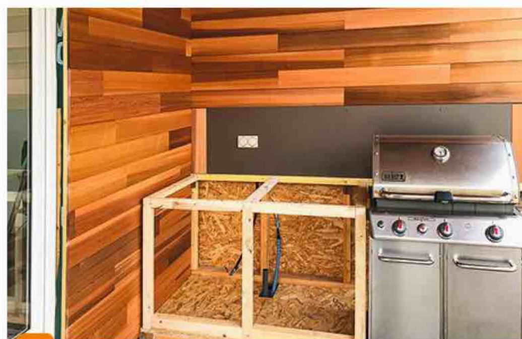
8 Pour l'aménagement de la cuisine et la création des meubles, notre lecteur utilise les chutes du chantier : montants bois, panneaux stratifiés ou lames de Red Cedar. Le barbecue est intégré à l'ensemble.
