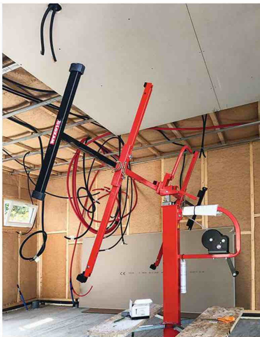
7 À l'intérieur, après avoir mis en place les panneaux isolants en laine de bois entre les montants de la structure, notre lecteur passe les réseaux avant de réaliser le faux plafond. L'ensemble est cloisonné avec des plaques de plâtre : « Je les ai peintes ensuite au pistolet. »
