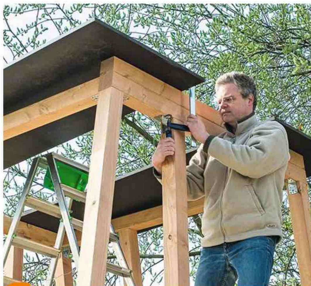
11 La couverture est hissée sur l'ossature après tirefonnage de la traverse de rehausse. Les deux panneaux latéraux sont vissés sur les traverses avec des vis munies de rondelles d'étanchéité.
