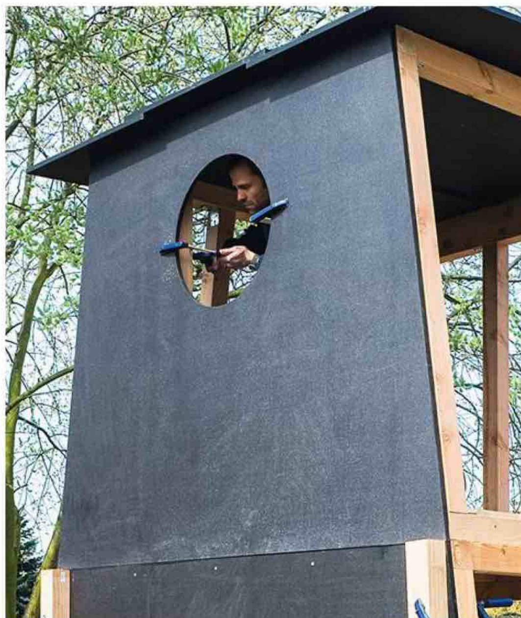
12 Les trois panneaux d'habillage sont bridés en place avec des serre-joints, puis vissés ou boulonnés à la charpente. Les ouvertures ont été découpées au préalable.
