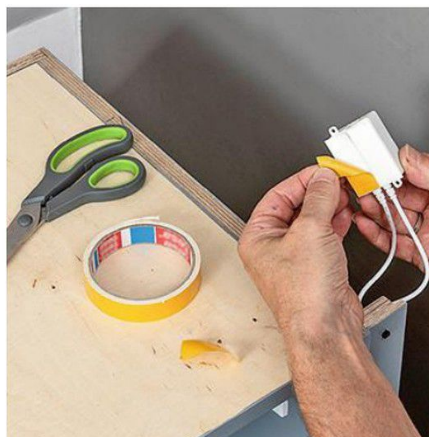
17 Placez de l'adhésif double face au dos du transformateur et collez-le sur l'extérieur du montant, derrière le fileur, en pressant fortement pour bien le faire adhérer.
