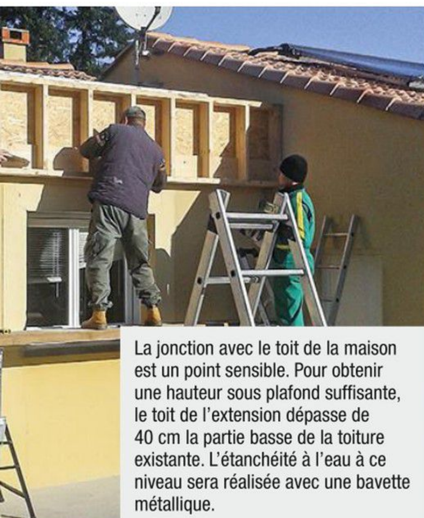
Le montage des parois s'effectue sur une lisse en bois solidarisée au muret. Entre les deux, une bande résiliente assure l'étanchéité.
