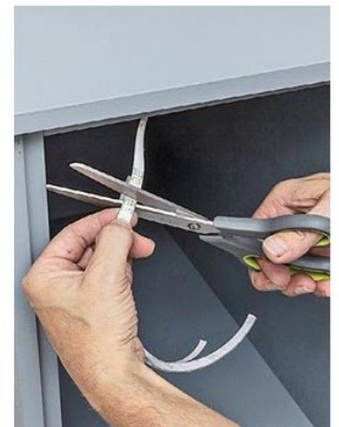
15 Arrivé à l'extrémité du placard, coupez le ruban à dimension avec des ciseaux. Il comporte à intervalles réguliers des marques prédéfinies.
