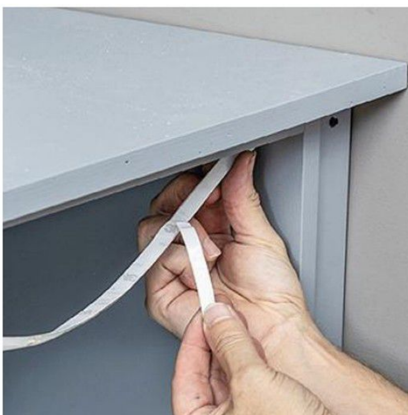
16 Délicatement, retirez le film protégeant la face adhésive du ruban et plaquez-le tendu sous les tablettes hautes. Marouflez avec le doigt de bout en bout.
