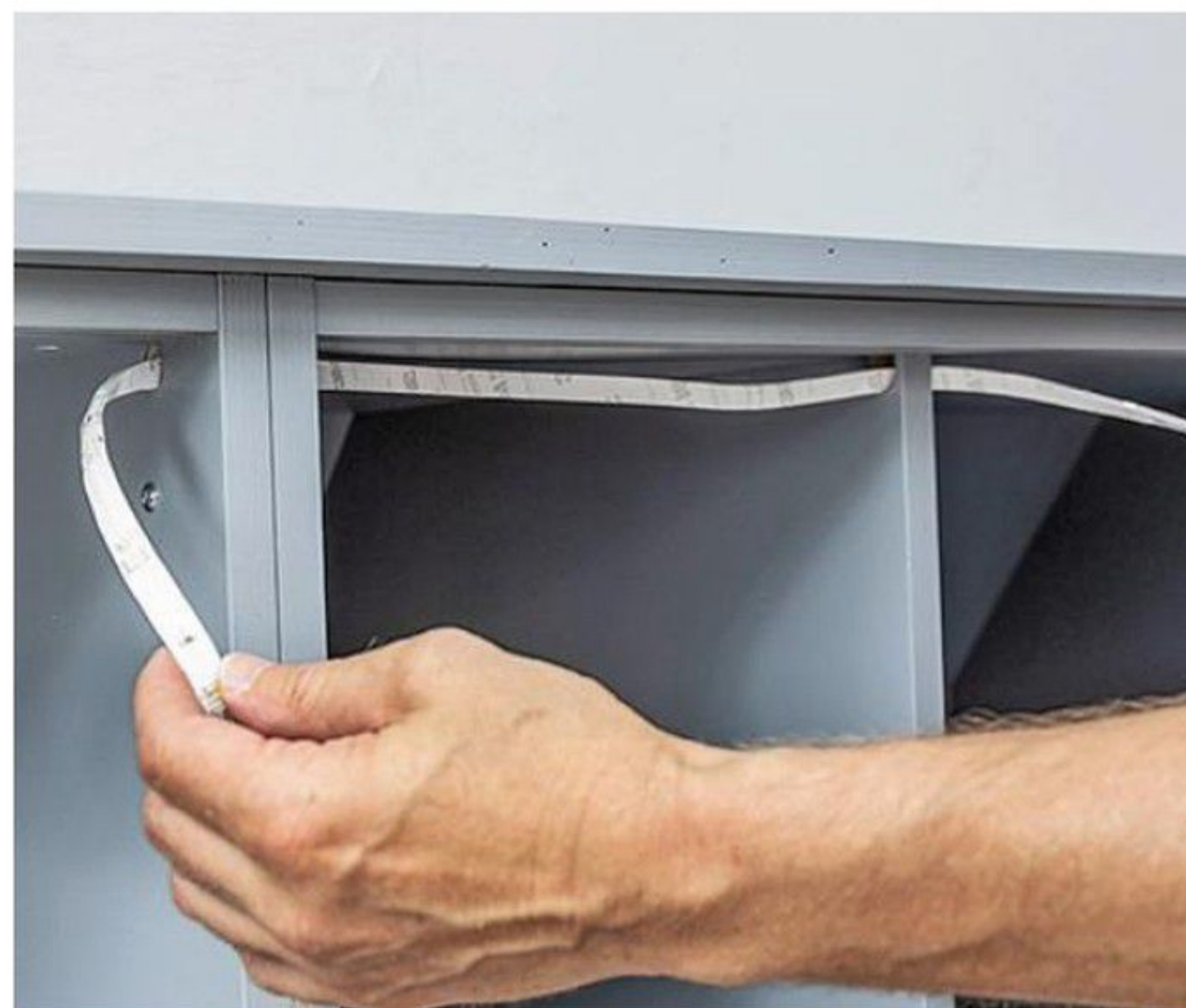
14 Faites circuler le ruban led d'un bout à l'autre du meuble en le faisant passer à travers les perçages.
