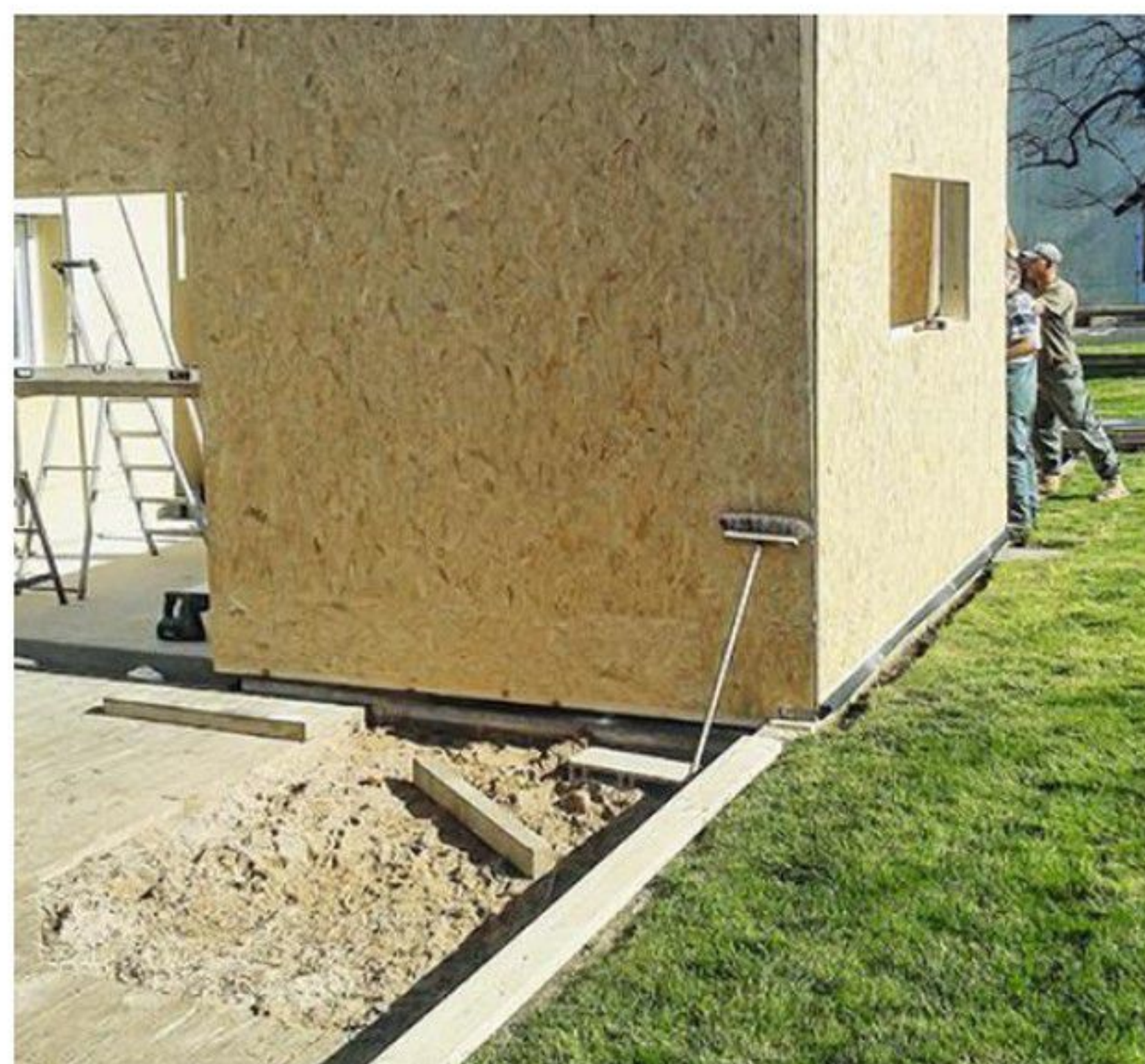
Le montage des parois s'effectue sur une lisse en bois solidarisée au muret. Entre les deux, une bande résiliente assure l'étanchéité.
