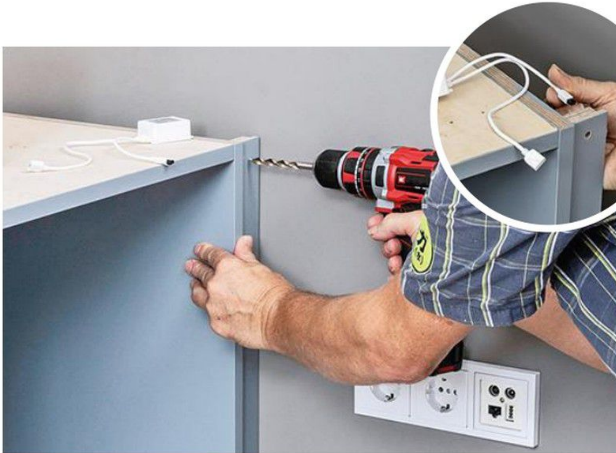
12 Le fileur en place, percez Ø 8 mm à 20 mm du haut. Le trou permettra de passer le détecteur du pilotage du ruban led.
