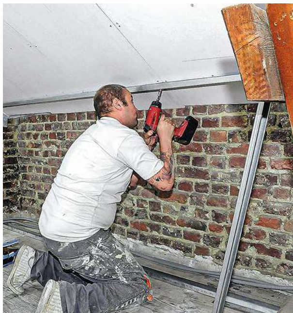
19 Mesurez la hauteur entre la lisse basse et le doublage et découpez deux montants. Positionnez la lisse haute. Vissez-la sur la fourrure située derrière la plaque de plâtre.
