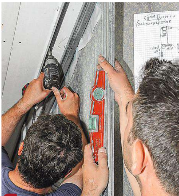
16 Fixez la lisse haute sur les fourrures de la soupente. Contrôlez à l'aide d'un niveau à bulle la verticalité au fur et à mesure de la fixation.
