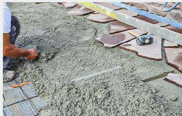
13 Posez les premières dalles de pierre en grès contre la bande de mousse. Positionnez-les dans le béton frais et tapotez pour les caler. À l'aide d'une règle métallique, égalisez la couche de béton et ajustez à la truelle, au fur et à mesure de la pose des dalles.
