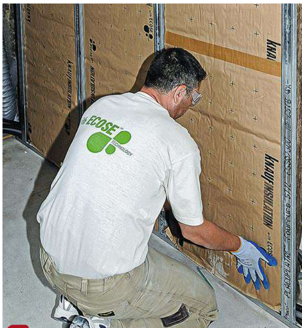
18 Insérez les panneaux isolants semi-rigides les uns sur les autres entre les fourrures (papier kraft vers vous). Ainsi maintenus, ils sont parfaitement stables.
