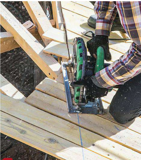
17 Les voliges sont recoupées à la scie circulaire. La profondeur de coupe doit être réglée précisément pour ne pas entamer l'arbalétrier.
