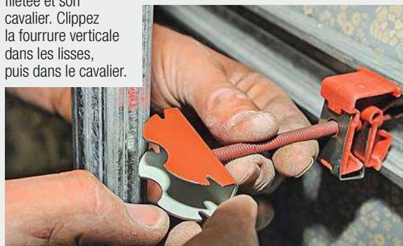
16 Fixez la lisse haute sur les fourrures de la soupente. Contrôlez à l'aide d'un niveau à bulle la verticalité au fur et à mesure de la fixation.
