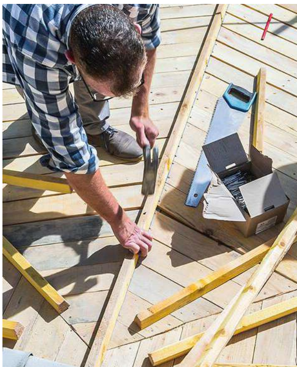
19 Un premier tasseau – à profil trapézoïdal – est cloué sur l'axe médian de l'arbalétrier principal : celui qui délimite les pans de toiture.
