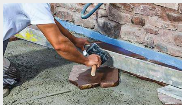
13 Posez les premières dalles de pierre en grès contre la bande de mousse. Positionnez-les dans le béton frais et tapotez pour les caler. À l'aide d'une règle métallique, égalisez la couche de béton et ajustez à la truelle, au fur et à mesure de la pose des dalles.
