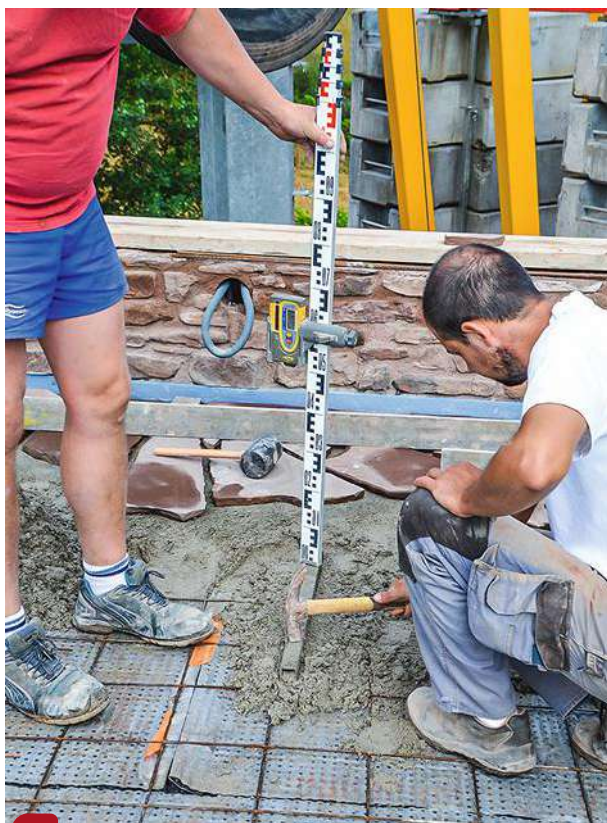
12 Plantez une pique pour contrôler l'épaisseur de la future dalle (5 cm) et prévoir la pente d'évacuation des eaux de pluie (2 à 3 cm/m).
