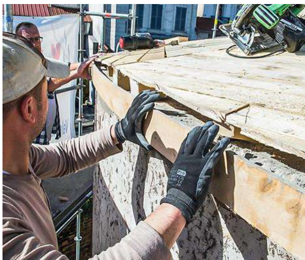
21 Le voligeage est bordé par des rives, lames de 2 m (ép. 10 mm). Elles sont cintrées en prenant appui sur les extrémités des arêtiers et chevrons, et clouées au fur et à mesure.
