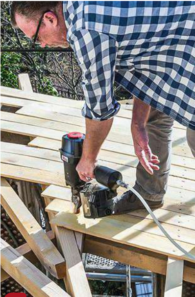
15 Les voliges sont fixées au centre par un cloueur pneumatique à partir de la périphérie. Elles sont serrées au fur et à mesure pour qu'elles ne se décalent pas.
