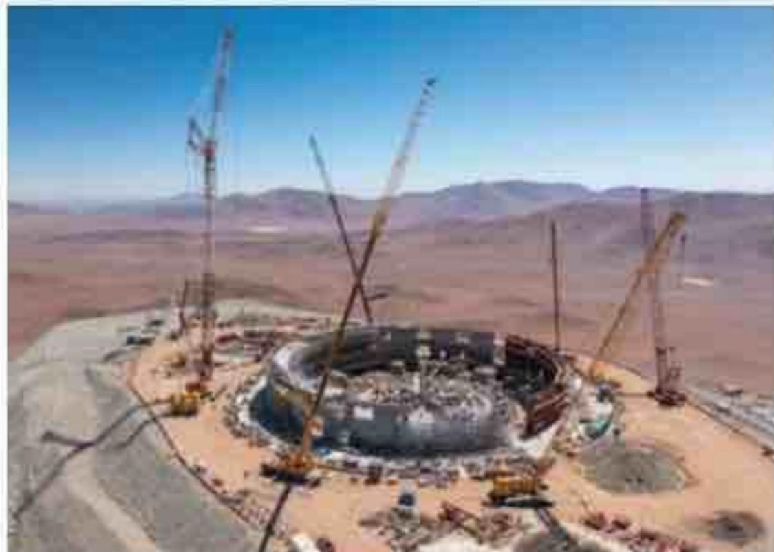
Dans le désert d'Atacama, la structure primaire en béton de l'ELT (ici, en octobre 2022) entourera une enceinte tournante de 6 100 t, qui permettra une rotation à 360° du dôme en acier de 84 m de haut.
