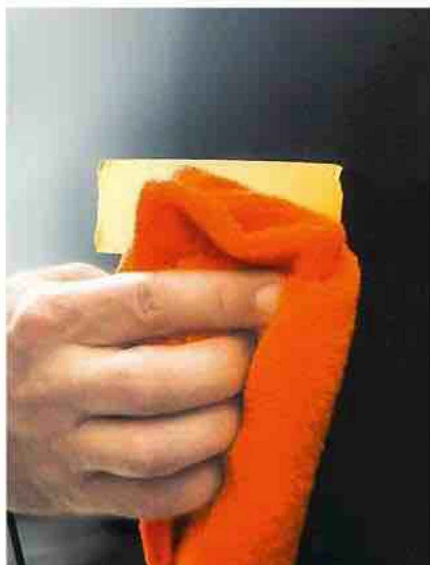
4 Ensuite, nettoyez et dépoussiérez la surface au chiffon doux, en le passant rapidement dessus.
