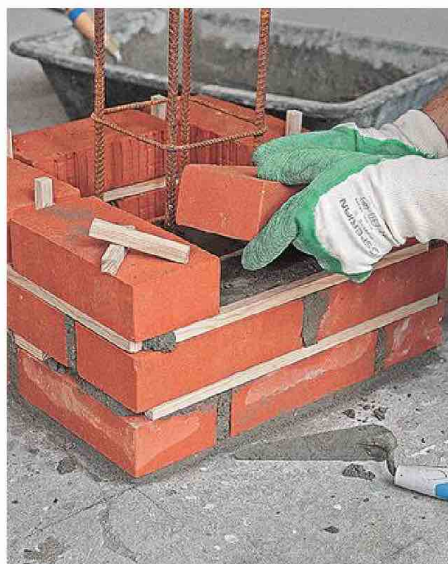
13/ Toujours en croisant les joints, procédez comme précédemment pour monter la troisième rangée.
