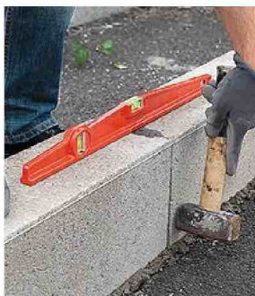
10/ Vérifiez à chaque fois le niveau et l'aplomb. Tapotez sur le côté pour rectifier l'alignement.
