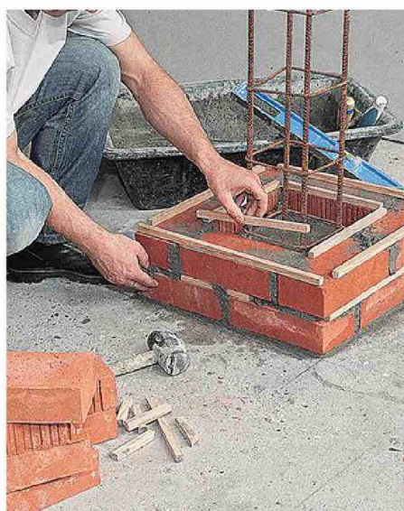
12/ Débitez de nouvelles cales et placez-les cette fois périphériques sur les pourtours internes et externes.
