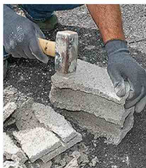
15/ Continuez à joints croisés avec des parpaings entiers. Taillez une chute à la dimension voulue pour terminer.
