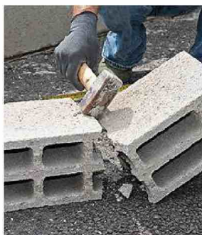
13/ Portez la mesure sur un parpaing entier. Réalisez la coupe au burin plat et à la massette ou à la meuleuse.
