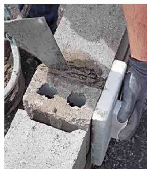
17/ Finissez de jointoyer. Pour suivre l'élévation, en remontant le cordeau d'alignement rang après rang.
