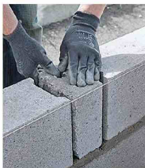
16/ Prenez soin, lors du calepinage, de ne pas faire coïncider la chute avec un joint de la rangée du dessous.
