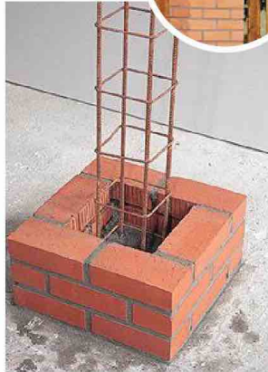
17/ Après 24 heures de séchage, reprenez le montage. Remplissez le vide de béton et posez le chapeau final.
