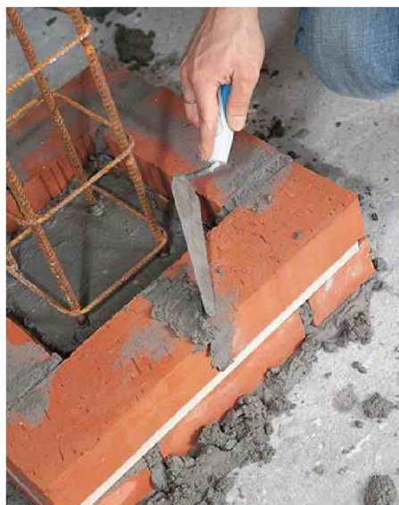
11/ Dès que la rangée est complète, comblez les joints de mortier en prenant soin de ne rien déplacer.
