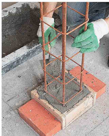
5/ Placez ensuite dans le béton une armature de chaînage vertical à quatre filants, en la centrant bien.
