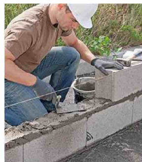
14/ Débutez le rang suivant en posant un bloc en quinconce sur les parpaings d'assise, à chaque extrémité.
