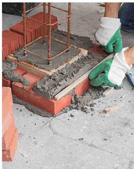
9/ Effectuez la pose du rang suivant, en réservant les joints périphériques avec des cales coupées à bonne longueur.
