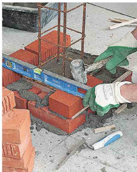
10/ Croisez les joints. Comme précédemment, contrôlez constamment le niveau et l'alignement des briques.
