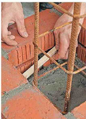
16/ Ensuite, retirez doucement et sans faire bouger les briques, les cales situées sur le pourtour intérieur de la maçonnerie.
