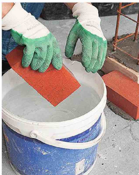
6/ Avant la pose des briques, plongez-les dans l'eau pour éviter un séchage trop rapide du mortier.
