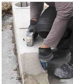
9/ Placez les parpaings d'assise intermédiaires en tapotant au marteau pour les caler dans le mortier.
