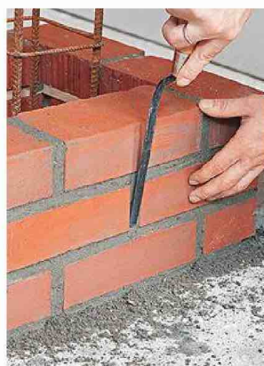
15/ Nettoyez à l'éponge humide le surplus de mortier en débord des briques, et lissez les joints au fer.
