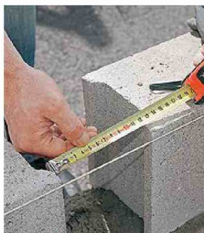
12/ Il faut souvent recouper l'avant-dernier parpaing pour combler la rangée. Mesurez l'espace restant.
