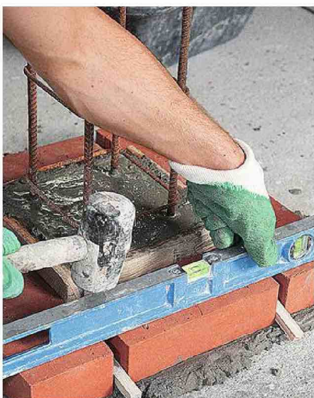
8/ Les cales assurent des joints réguliers. Contrôlez le niveau, l'alignement et l'aplomb de chaque brique.
