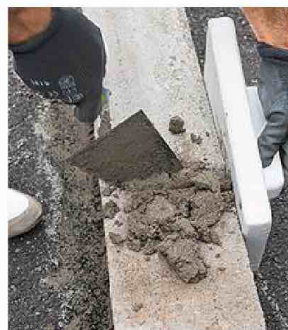
11/ Remplissez les joints au fur et à mesure. Garnissez-les bien, puis raclez l'excédent avec le fil de la truelle.
