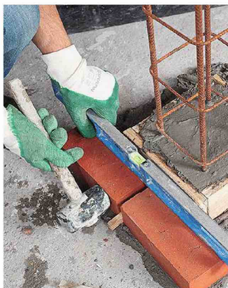
7/ Le mouillage améliore aussi l'adhérence du mortier. Posez les briques d'assise, en interposant les cales.
