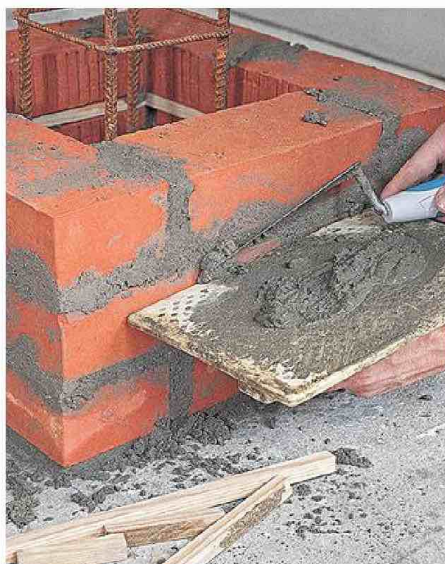
14/ À ce stade, retirez la totalité des cales et des guides périphériques, afin de terminer les joints.
