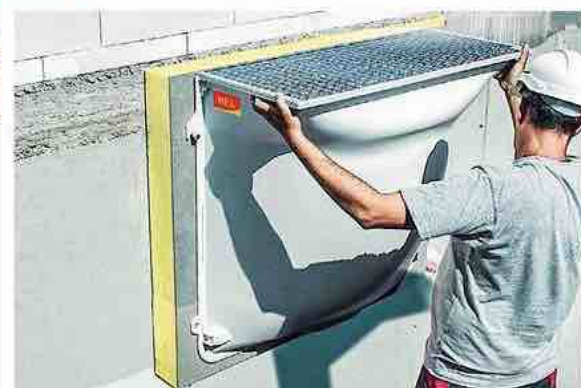
5 L'installation d'une cour anglaise (ici préfabriquée) implique d'abord de creuser une tranchée, puis d'ouvrir le mur pour y fixer un châssis vitré. L'étanchéité de l'ensemble doit être parfaite en tous points.
