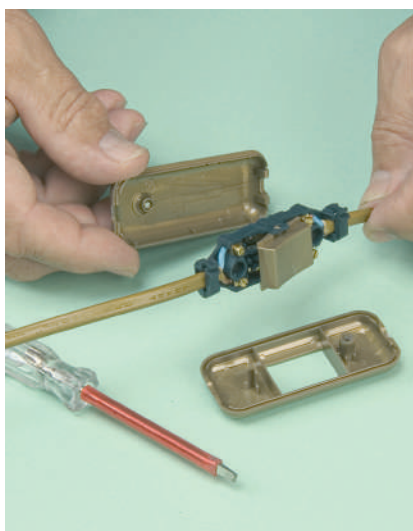
5 Ouvrez l'interrupteur olive. Sectionnez le câble d'alimentation de la lampe, dénudez les brins et serrez-les dans les plots de part et d'autre du bouton.
