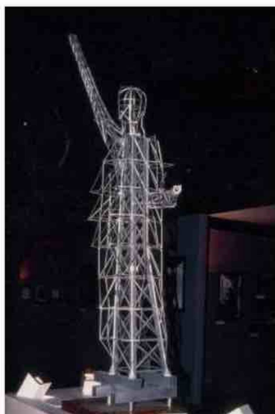
Structure métallique pour la statue de la Liberté, à New York.
