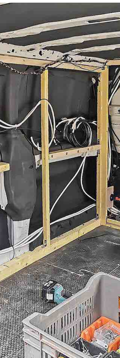
« J'ai peint le plafond en noir mat et posé des lattes recouvertes d'une finition pour protéger et conserver un aspect bois naturel. Cette étape fastidieuse m'a pris une semaine, car j'ai dû créer des gabarits, placer des étais et attendre le séchage des différentes lattes. »
