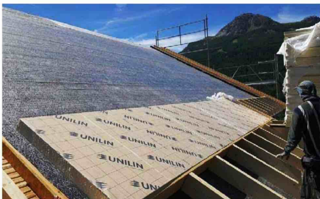
Les solutions de la gamme Utherm Sarking Anti-Slide sont revêtues d'un parement multicouche étanche avec traitement anti-dérapant, idéal pour le climat montagneux. UNILIN INSULATION
