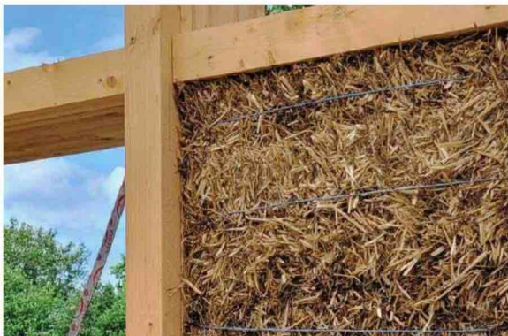
Biofib' paille est une solution d'isolation thermique écologique et économique. Légère, facile et rapide à mettre en œuvre, c'est un remplissage idéal des systèmes type mur et façade ossature bois. BIOFIB'
