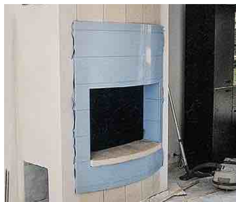
11 Pour finir, fixez la plaque décorative prévue autour du foyer, par chevilles et vis adaptées au plâtre. Certaines se posent avec un mastic de fixation haute température.
