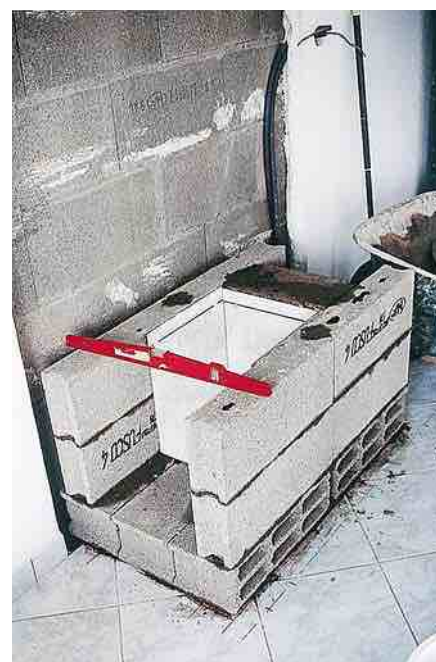
4 Montez le socle qui reste accessible sur un côté et est destiné à être carrelé. Vous pouvez conserver une cavité sous le foyer pour le stockage des bûches.
