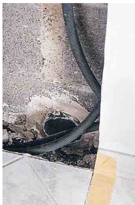
2 Le mur d'appui est percé en partie basse et il est traversé d'un conduit permettant d'amener l'air comburant depuis l'extérieur ou un local attenant.
