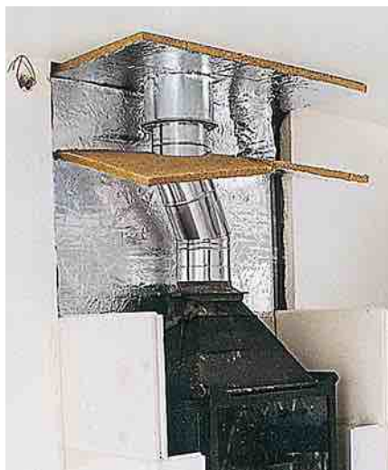
7 Installez l'avaloir au-dessus du foyer et reliez-le, avec un tuyau rigide et un raccord normalisé (réduction ou autre), au tubage du conduit de cheminée existant.
