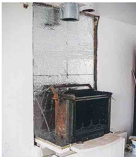
6 Isolez le mur en y collant des plaques de la laine de roche à face aluminium. Garnissez de même les côtés et l'arrière de la plaque foyer.
