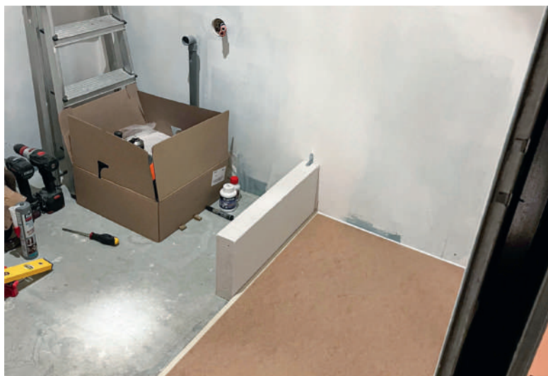
Des plaques de plâtre hydrofuges ont été mises en œuvre dans la partie salle de bains. Et une mousse expansive a traité les ponts thermiques dans la maison.
