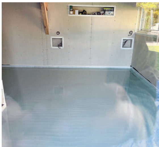
L'isolation réalisée, Adrien a coulé la chape en installant une toile en polyéthylène sur la dalle existante afin de désolidariser la chape pour éviter fissures et remontées d'humidité (lire encadré page suivante).
