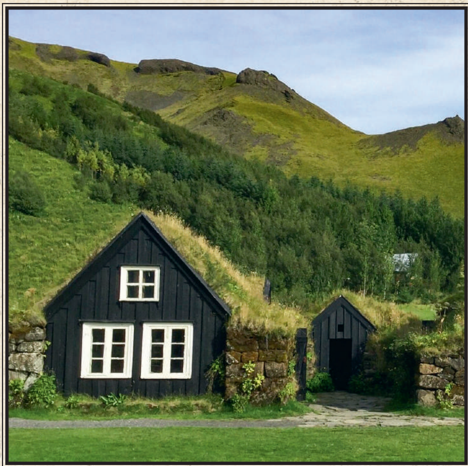
Bois, pierre, tourbe, toiture végétalisée font partie des principaux composants de la maison islandaise ancestrale, soumise aux rudesses de la météo locale.
