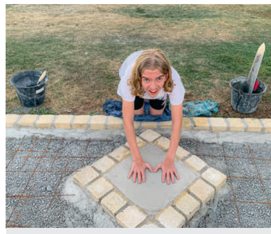
Avant de couler le béton désactivé, Thierry L. a conçu deux carrés en pavé remplis de béton, à l'aide de gabarits en bois, et sur lesquels ses enfants sont venus imprimer l'empreinte de leurs mains.
