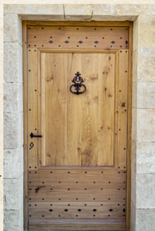
Reproduction d'une porte d'entrée de bastide médiévale en chêne massif, usinée à l'ancienne. Les lames sont «renforcées» par des clous forgés à tête losange. Le heurtoir et la poignée sont fidèles à l'esprit de l'époque...
