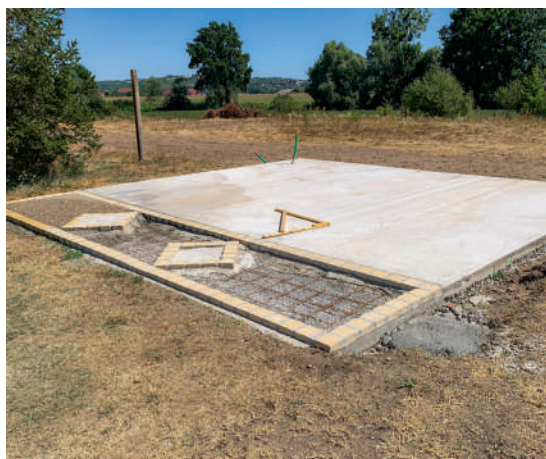
La future entrée du carport a été réalisée en béton désactivé et ferrillée, ce qui ajoute une petite note esthétique en rupture avec le reste de la dalle laissée brute. L'ensemble a été cerclé de pavés autobloquants (5 x 5 cm) achetés sur Leboncoin.
