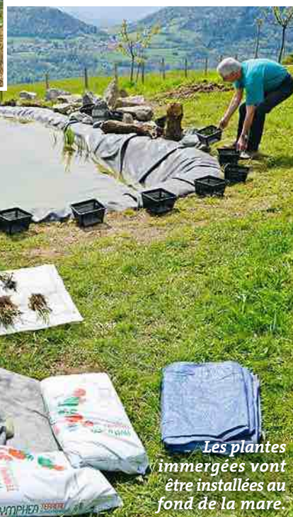
La mare est imperméabilisée avec un géotextile recouvert d'une bâche PVC.
