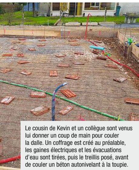
La dalle est d'une épaisseur qui varie de 13 à 16 cm par endroit. Suffisant pour assurer la stabilité de la structure du garage. Elle sera recouverte d'un produit de cure pour éviter les fissures.
