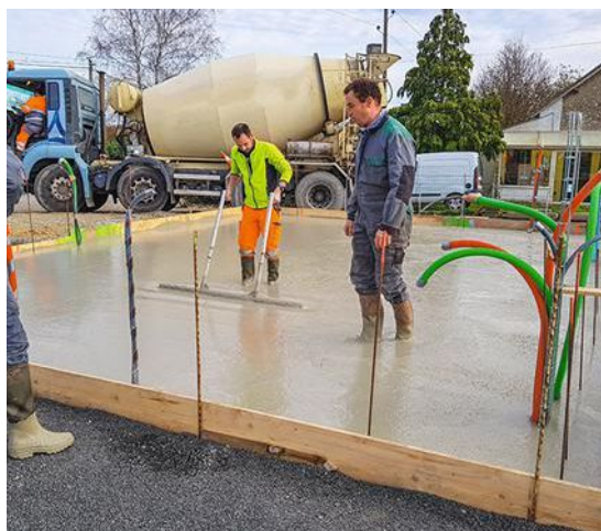
La dalle est d'une épaisseur qui varie de 13 à 16 cm par endroit. Suffisant pour assurer la stabilité de la structure du garage. Elle sera recouverte d'un produit de cure pour éviter les fissures.
