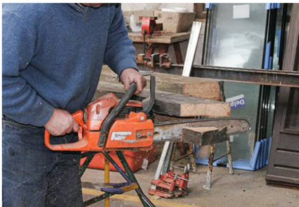
6 Recoupez les extrémités des pièces à la tronçonneuse. Cet outil permet de couper facilement les pièces de forte section.
