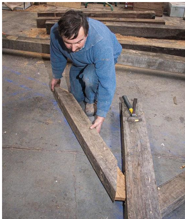
7 Réalisez un préontage au sol, à l'aplomb de l'épure, afin de vérifier la pénétration des assemblages à tenon et mortaise et les dimensions générales des pièces.
