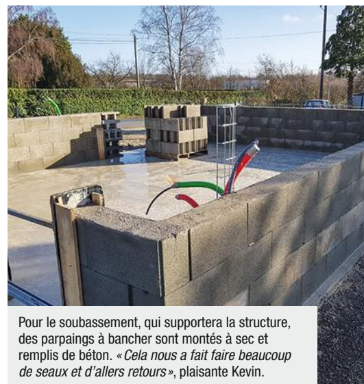
La dalle est d'une épaisseur qui varie de 13 à 16 cm par endroit. Suffisant pour assurer la stabilité de la structure du garage. Elle sera recouverte d'un produit de cure pour éviter les fissures.
