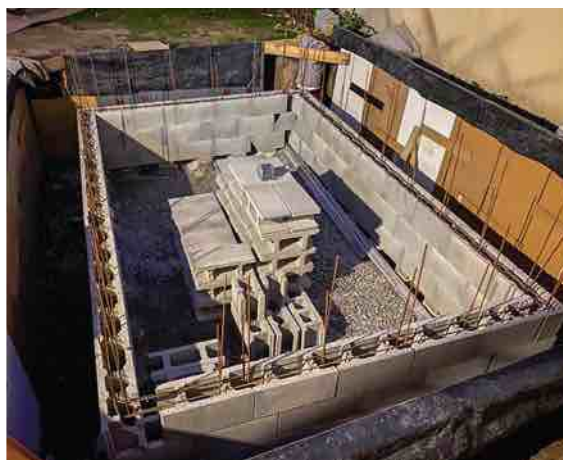
Le fond est ensuite empierré et un coffrage installé pour éviter toute chute de terre pendant la durée des travaux. La structure, composée de 260 blocs de béton à bancher, est montée, puis ferrillée à l'horizontale et à la verticale.
