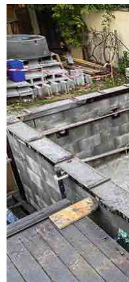
Le fond est ensuite empierré et un coffrage installé pour éviter toute chute de terre pendant la durée des travaux. La structure, composée de 260 blocs de béton à bancher, est montée, puis ferrillée à l'horizontale et à la verticale.
