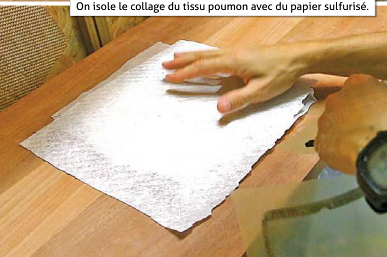
On isole le collage du tissu poumon avec du papier sulfurisé.
