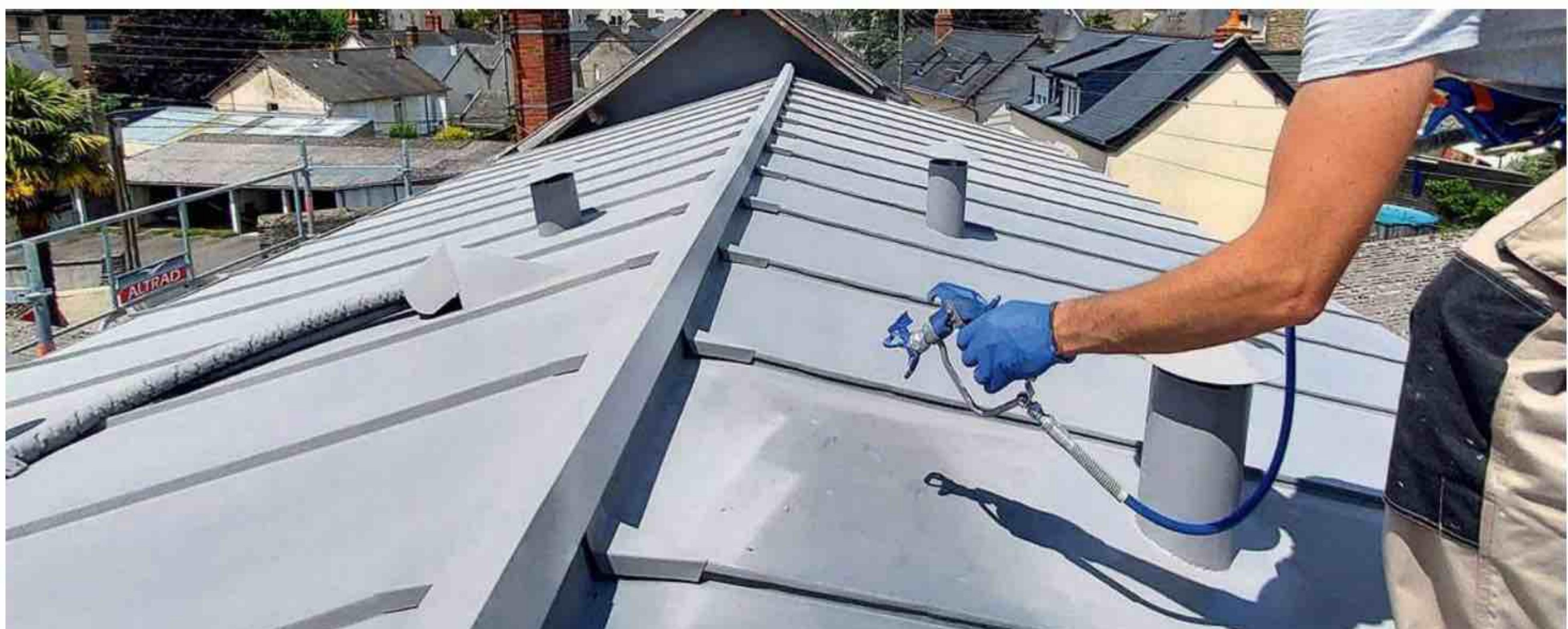
Peinture d'isolation ultra technique, **ThermaCote** améliore l'isolation thermique, l'étanchéité à l'air et préserve de l'humidité en agissant comme une couverture de survie sur les toitures et façades en métal, briques, ciment, béton ou plaques de plâtre. Constitué à 80 % de céramique, ce produit révolutionnaire s'applique par pulvérisation.
