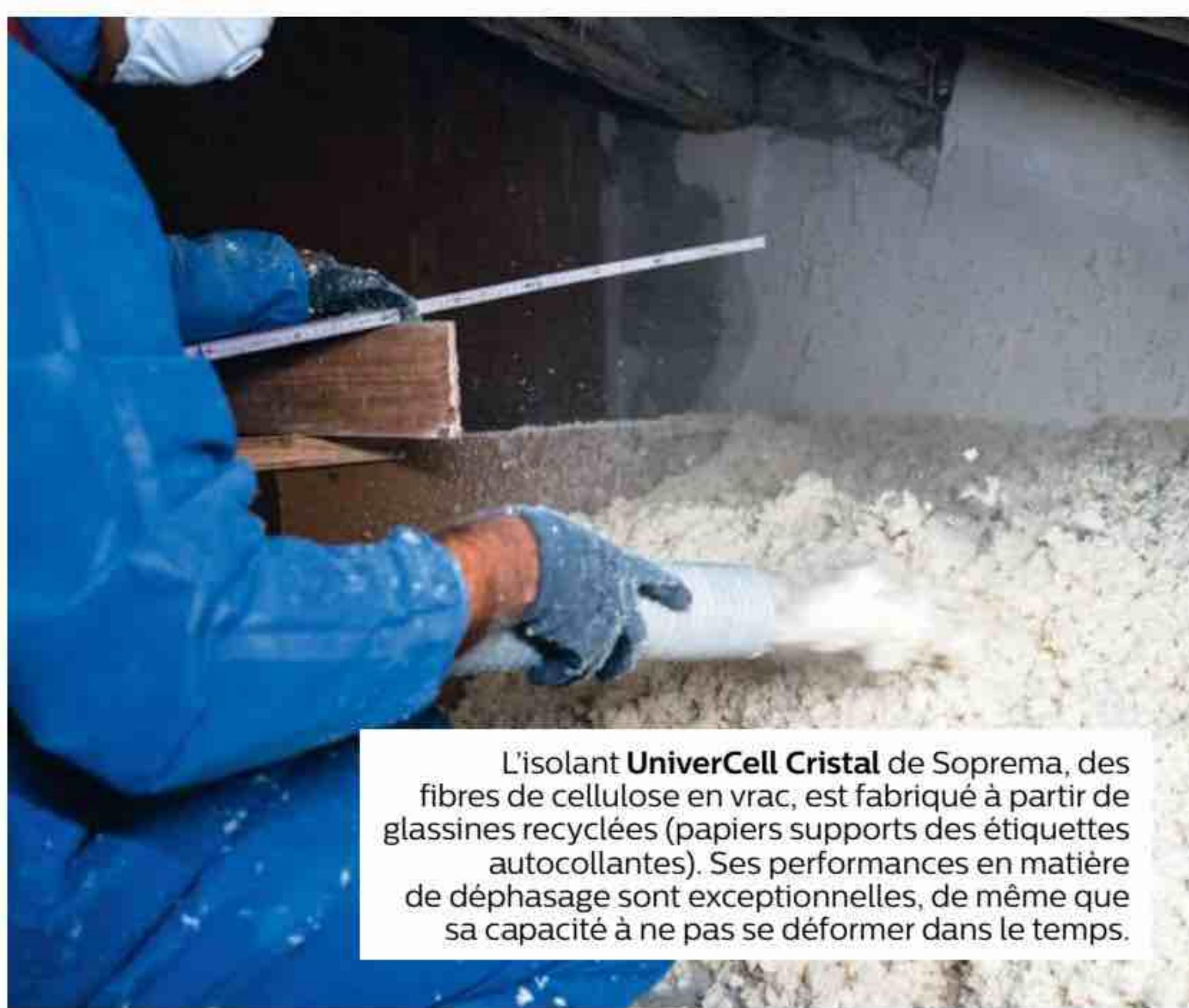
L'isolant **UniverCell Cristal** de Soprema, des fibres de cellulose en vrac, est fabriqué à partir de glassines recyclées (papiers supports des étiquettes autocollantes). Ses performances en matière de déphasage sont exceptionnelles, de même que sa capacité à ne pas se déformer dans le temps.
