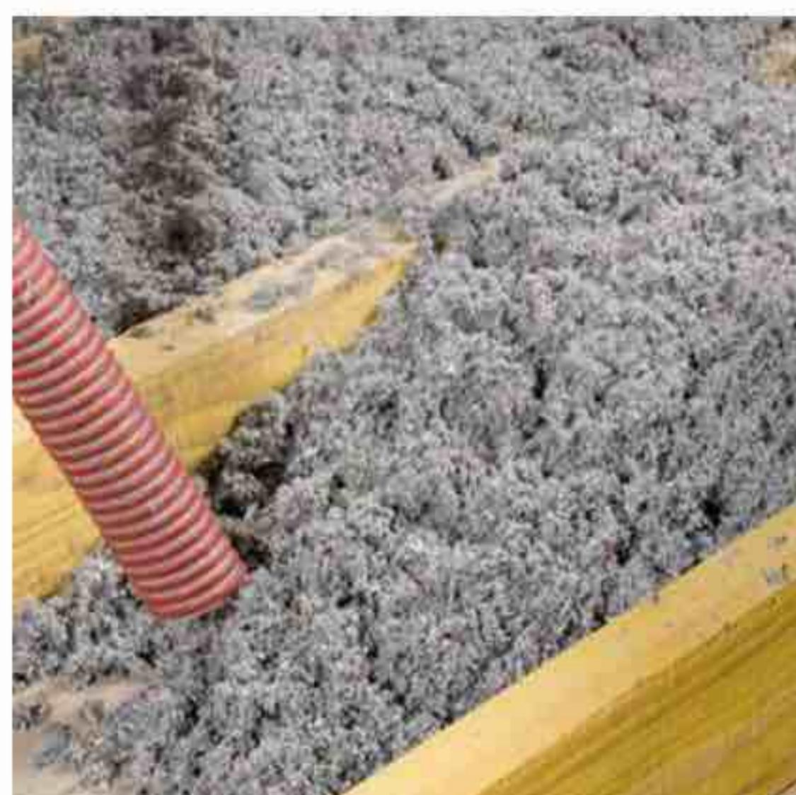
Grâce à sa forte densité et à ses bonnes performances en matière d'inertie et de déphasage, la **ouate de cellulose** fait partie des isolants les plus couramment mis en œuvre dans les combles.
