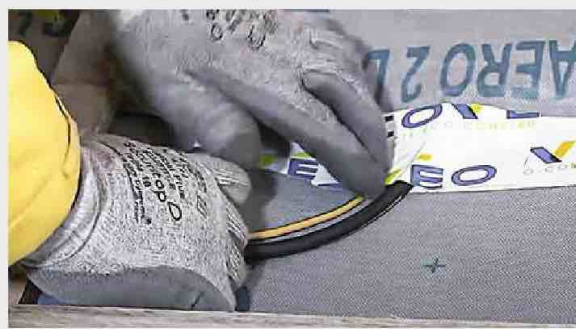
11 Après avoir finalisé les raccordements extérieurs, on passe les deux câbles, d'alimentation et de terre, entre deux lés de l'écran de sous-toiture. Le chevauchement est ensuite recouvert d'un large adhésif pour rétablir l'étanchéité à l'air.
