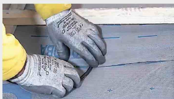
11 Après avoir finalisé les raccordements extérieurs, on passe les deux câbles, d'alimentation et de terre, entre deux lés de l'écran de sous-toiture. Le chevauchement est ensuite recouvert d'un large adhésif pour rétablir l'étanchéité à l'air.
