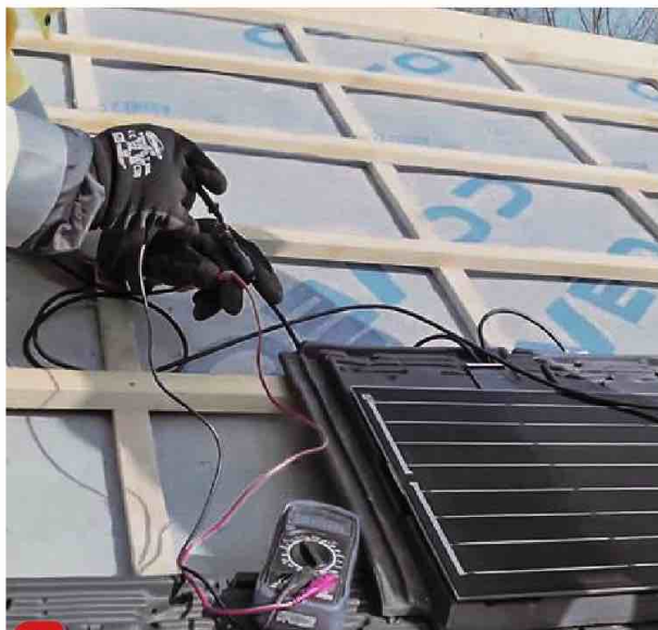
8 Une fois la rangée terminée, sa tension est testée avec le voltmètre (valeur \neq 0 ).
