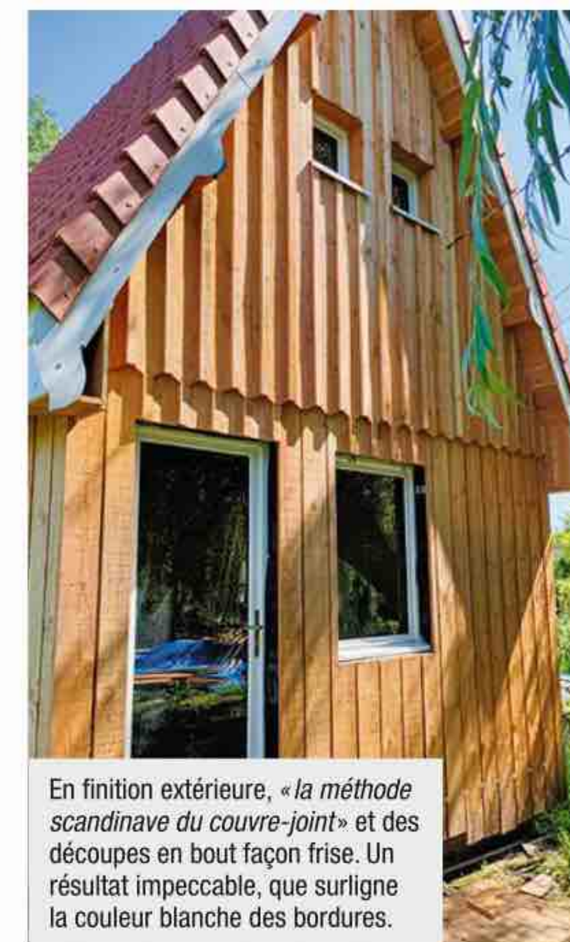
Le moment est venu de terminer les pignons, dont la partie supérieure (triangulaire) était restée en l'état. Notre lecteur profite de la mise à nu pour préparer l'ajout de deux petits châssis.
