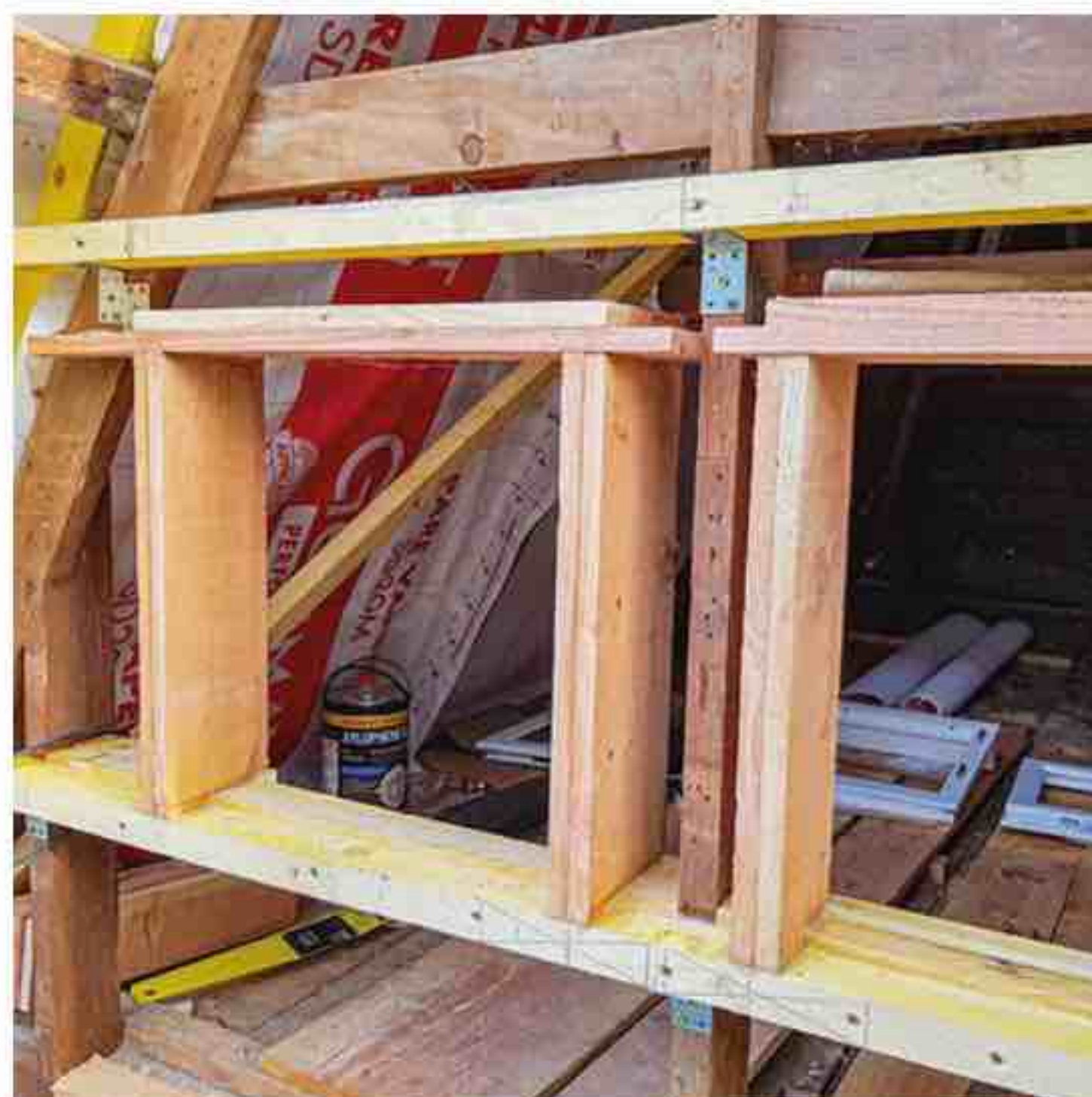
Le moment est venu de terminer les pignons, dont la partie supérieure (triangulaire) était restée en l'état. Notre lecteur profite de la mise à nu pour préparer l'ajout de deux petits châssis.
