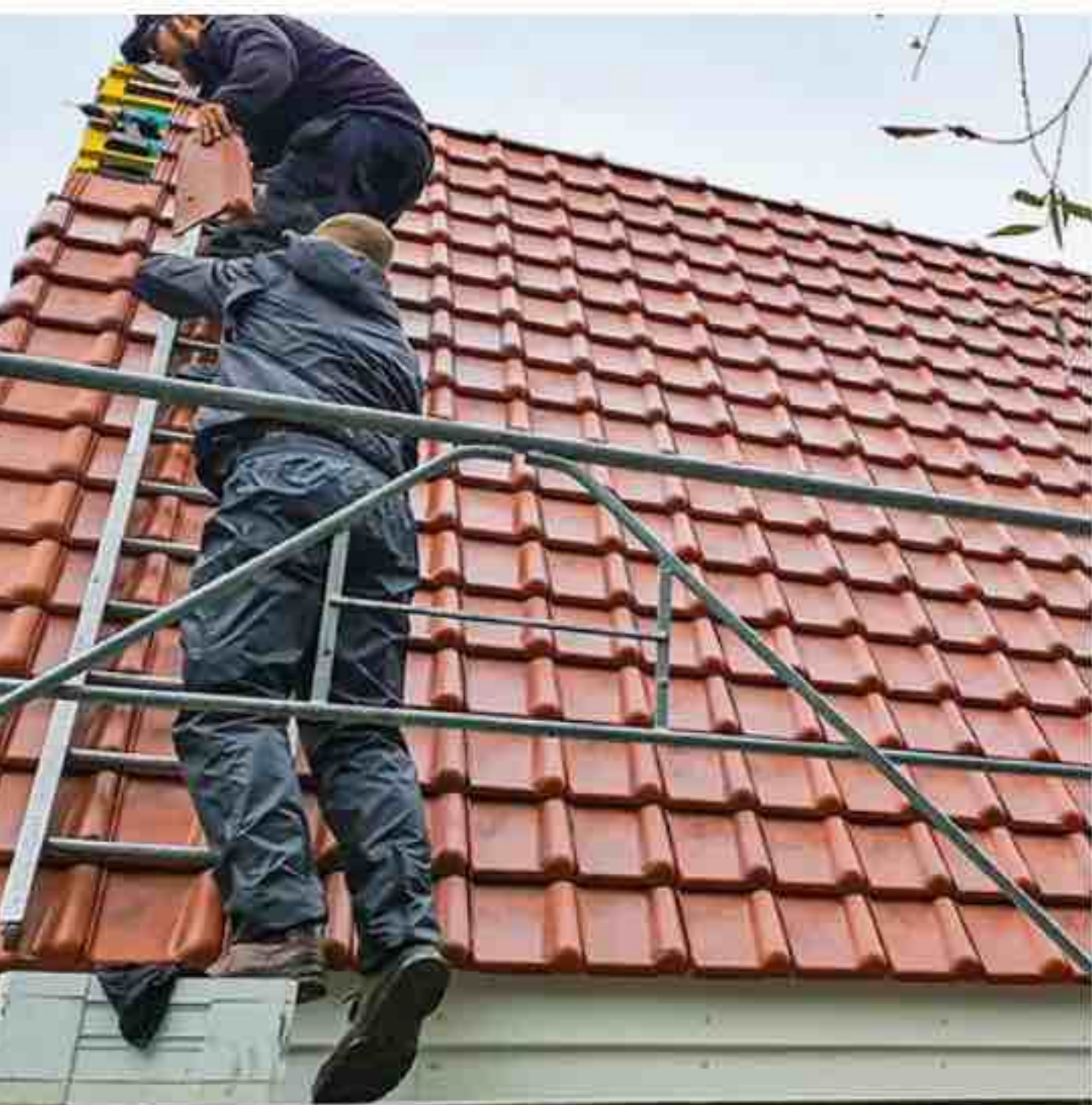
Le travail de couverture se fait en remontant de l'égout au faîtage et d'une extrémité à l'autre du toit. Des tuiles faîtières et de rive parachèvent la mise en œuvre.
