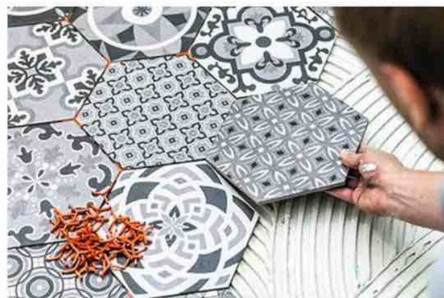
5 Les carreaux hexagonaux se posent à l'aide de croisillons spéciaux adaptés à leurs six côtés.
