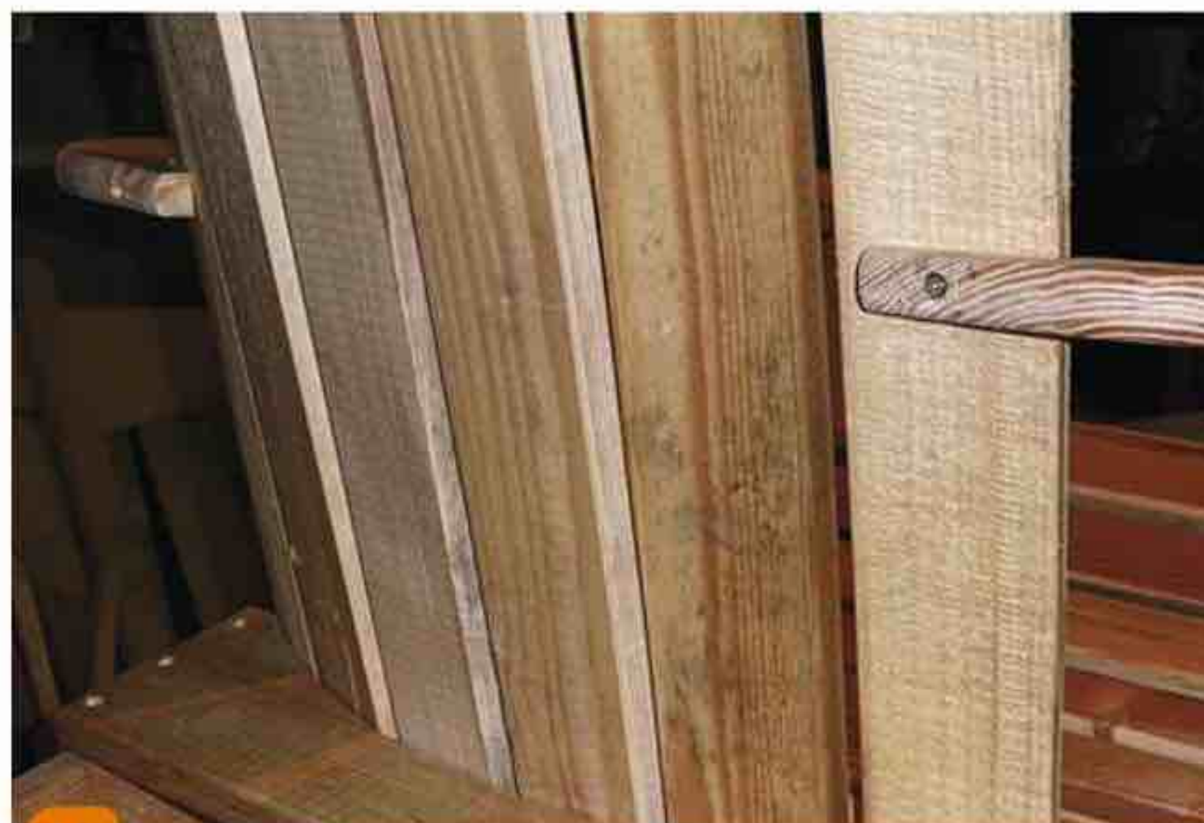
14 À l'arrière, les accoudoirs (ép. 30 mm) sont échancrés de façon à se visser sur le dossier.
