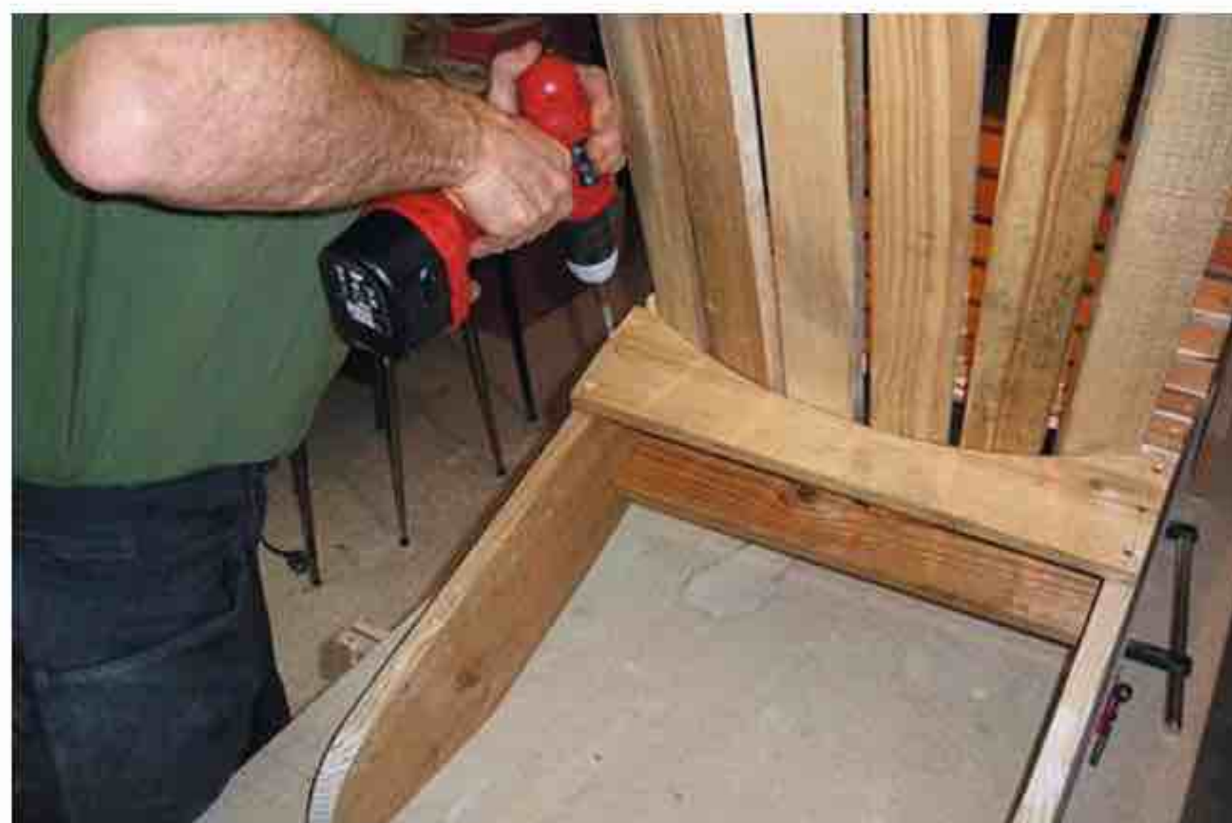
11 Placez le dossier sur le piètement arrière, derrière l'assise. La traverse basse s'insère entre les pieds. L'intermédiaire repose sur le piètement (6 vis 4 x 50 mm).
