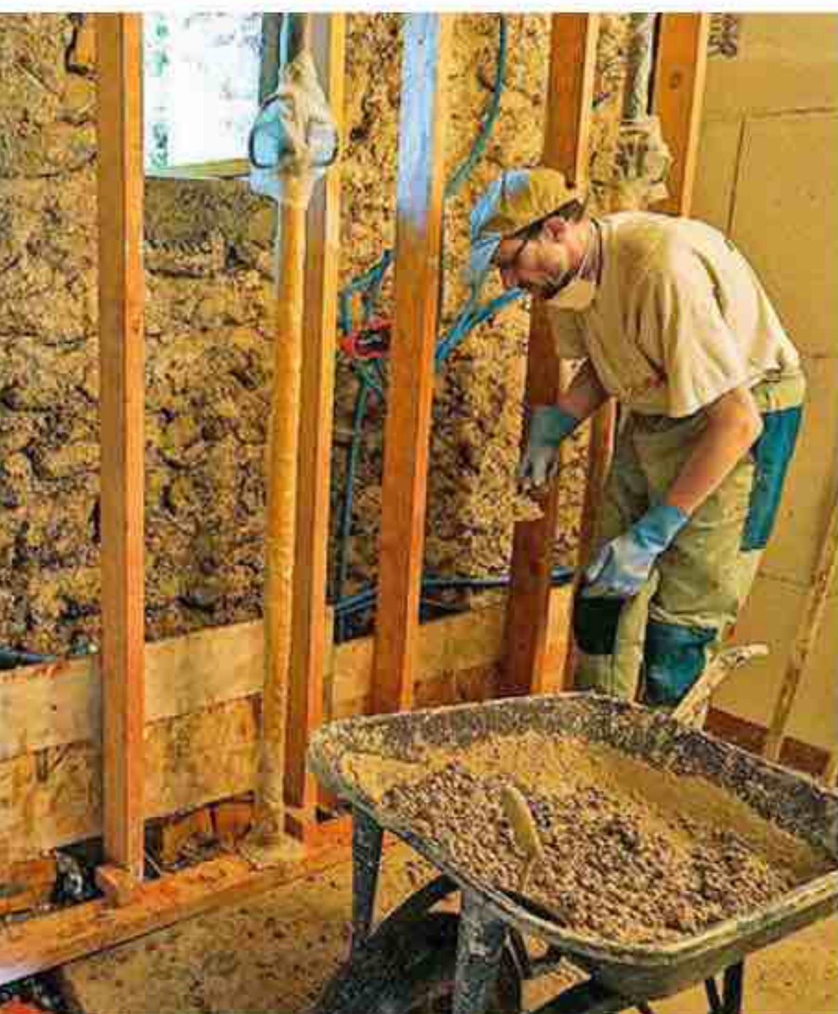
Le torchis est appliqué manuellement sur 5 à 8 cm d'épaisseur. Plusieurs jours de séchage s'imposent entre les couches. Le lissage final s'exécute à la truelle ou au platoir inox.
