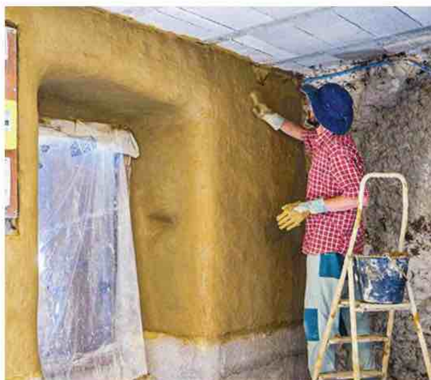
Le torchis est appliqué manuellement sur 5 à 8 cm d'épaisseur. Plusieurs jours de séchage s'imposent entre les couches. Le lissage final s'exécute à la truelle ou au platoir inox.
