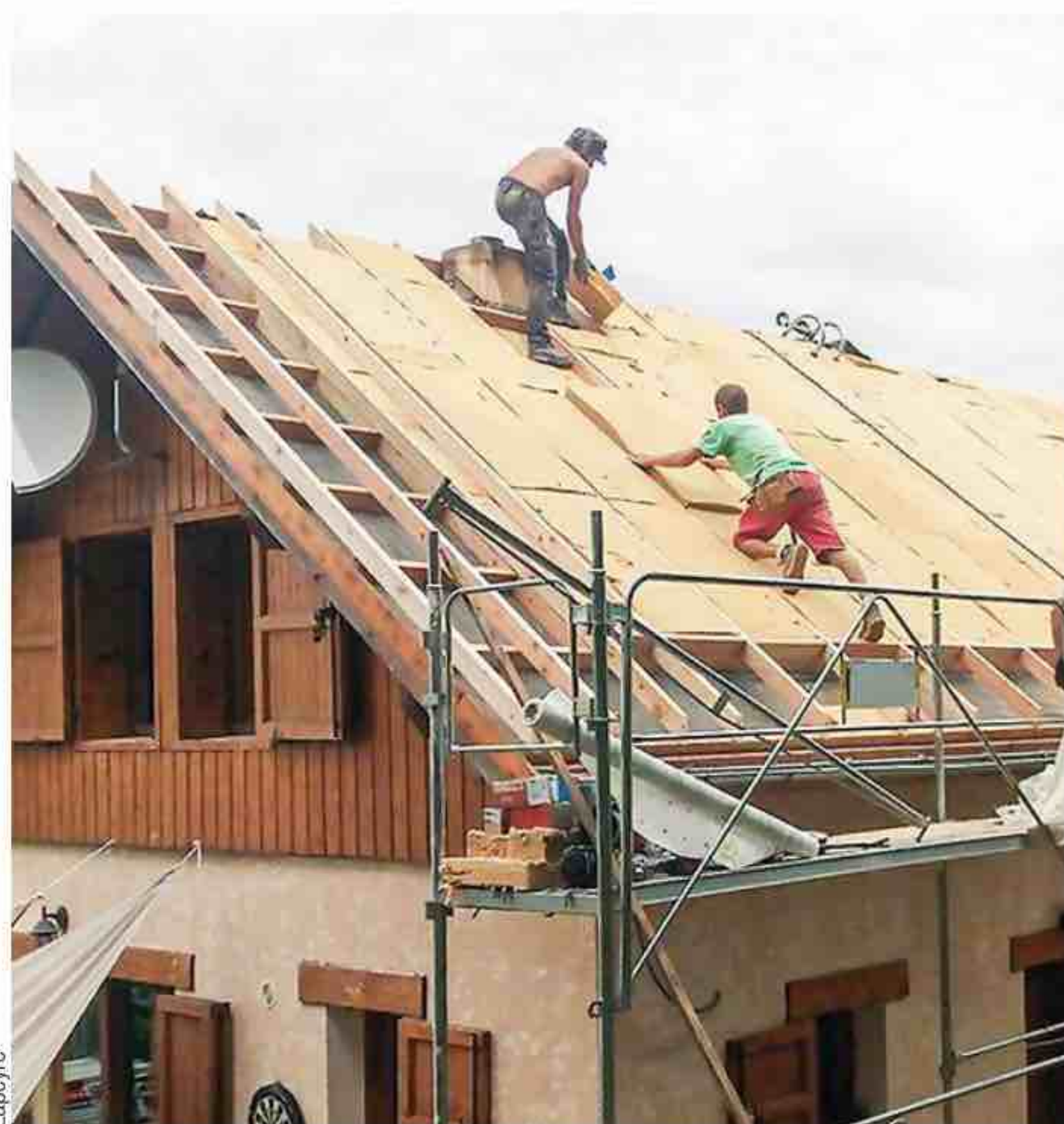
2 L'isolation par l'extérieur (ITE) permet de conserver la charpente apparente et d'éliminer les ponts thermiques. Elle préserve la hauteur sous plafond et offre une solution durable sur le plan énergétique.
