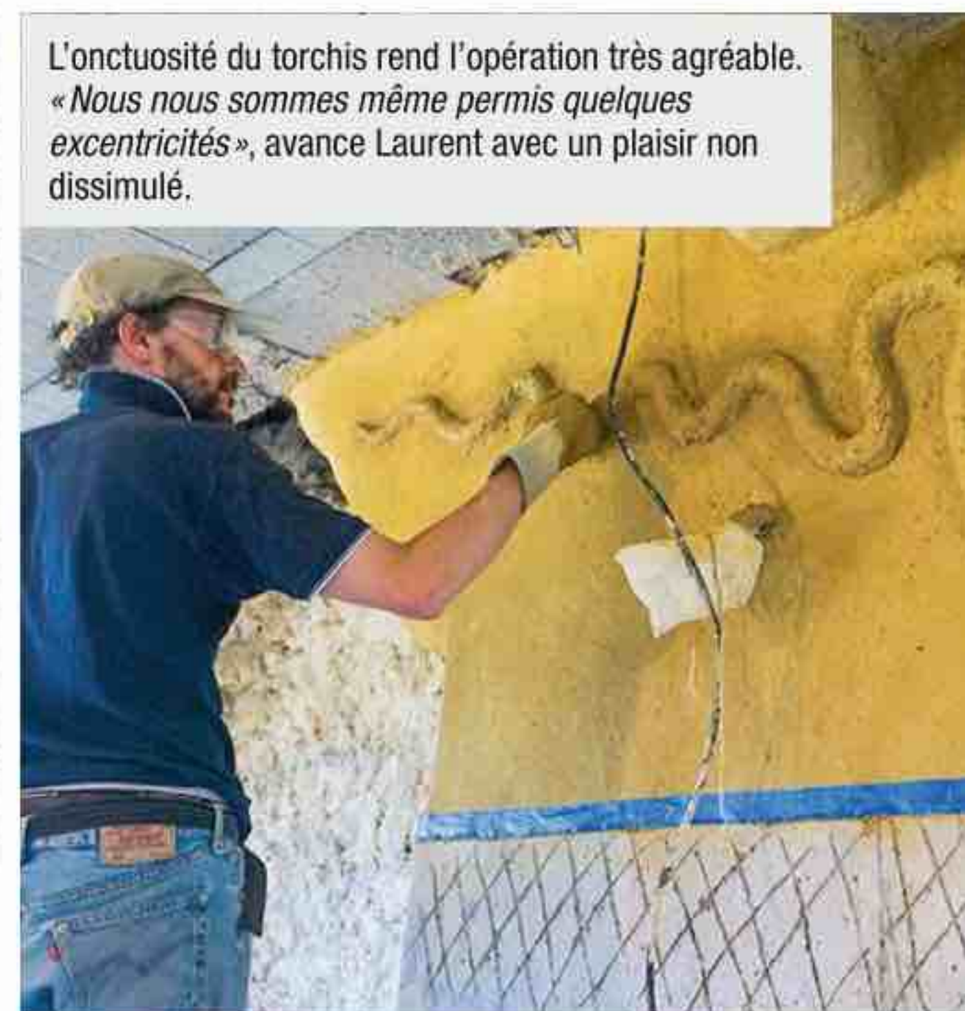
Le torchis est appliqué manuellement sur 5 à 8 cm d'épaisseur. Plusieurs jours de séchage s'imposent entre les couches. Le lissage final s'exécute à la truelle ou au platoir inox.
